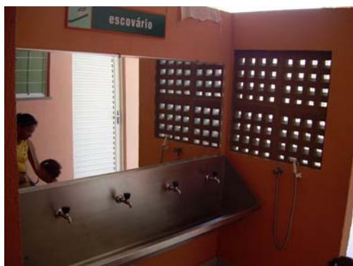
Fig. 56 - Vista do escovário ventilado e protegido da chuva lateralmente por um cobogó de concreto.
