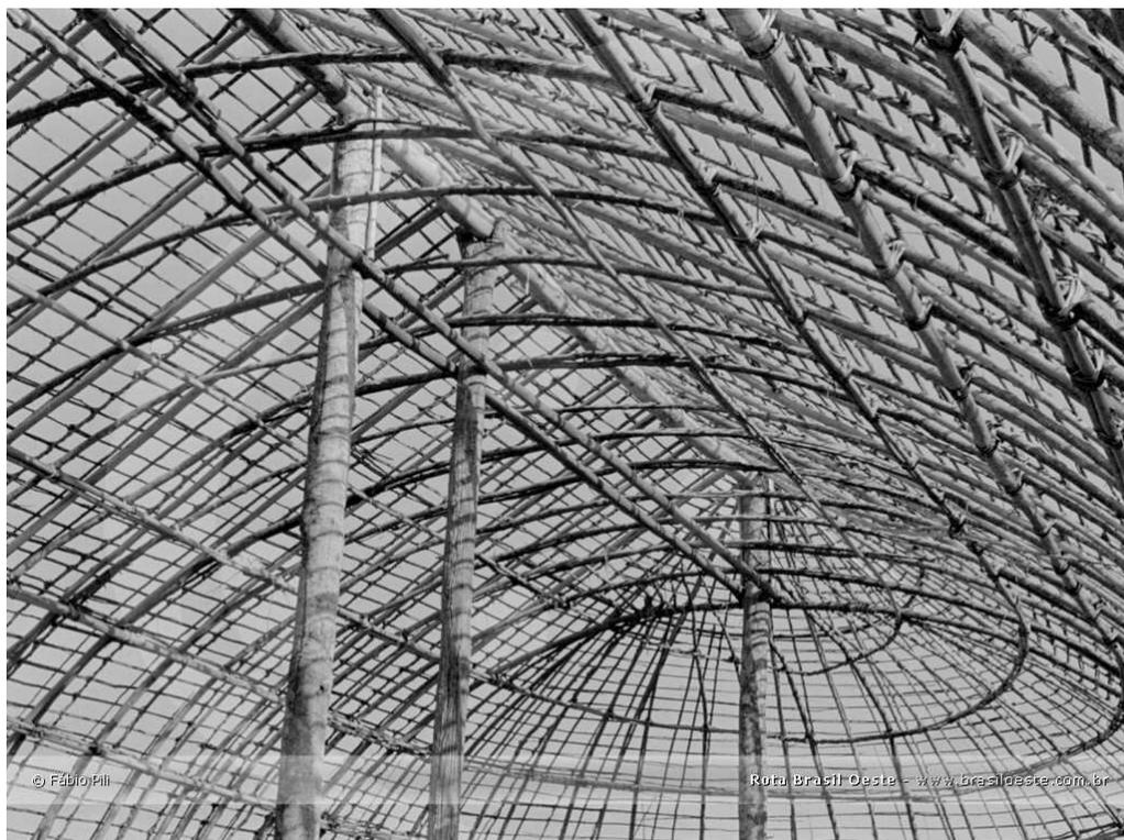
Fig. 1 – Ilustração de um sistema de construção de uma oca, a moradia dos índios. Um tipo de edificação não permanente mas que não deve ser considerada como provisória pois como povos nômades, tempos depois a ela retornavam.
