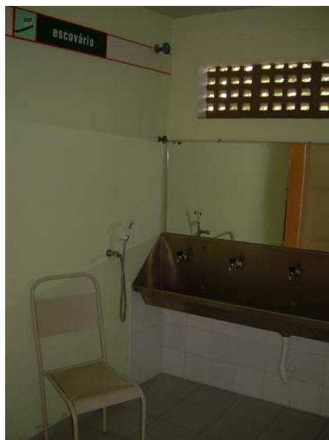
Fig. 21 – A área do escovário possui ventilação natural permanente, por meio de cobogós de concreto.
