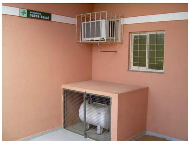
Fig. 57 – Vista do exterior da edícula construída fora da Sala de Saúde Bucal para abrigar o compressor.
