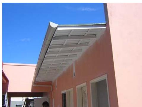
Fig. 34 – Vista do telhado durante a obra após receber pintura branca a base de PVA.
