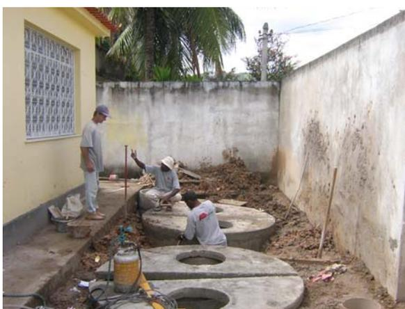
Fig. 40 – Detalhe da execução da fossa e do filtro do PSF.
