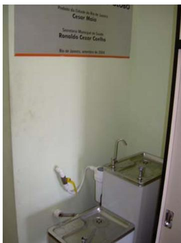
Fig. 64 – Detalhe do pré-filtro do bebedor.
