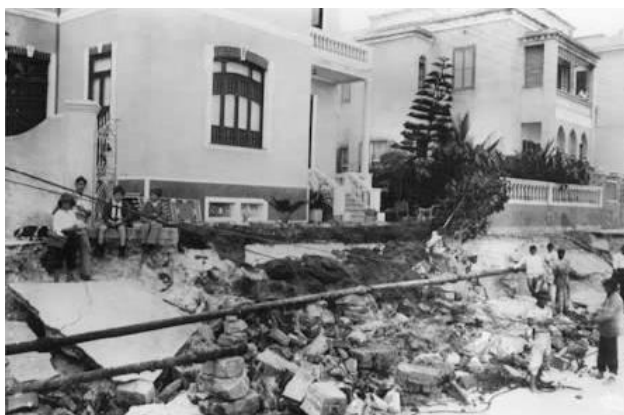
Imagem 46: Calçamento da Avenida Atlântica destruído após a forte ressaca de 1919. Foto de Malta. Casa de Rui Barbosa. Fonte: COSTA, Eliane (org.). Circuito Copacabana (CD Rom). Sonopress-Rimo. São Paulo, 2002.
