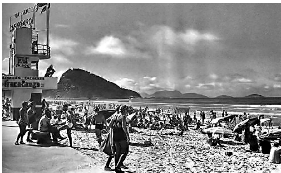
Imagem 65: O novo posto de salvamento da década de 30. Fonte: http://fotolog.terra.com.br/luizd:145 em 26/06/2006.
