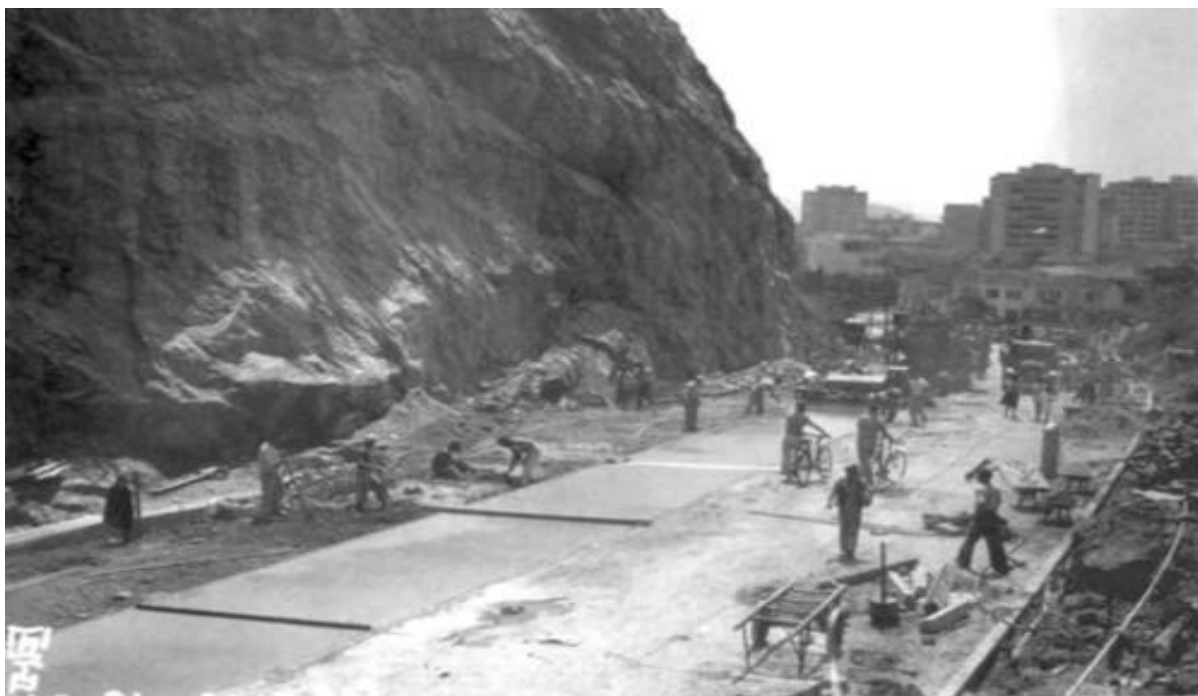
Imagem 76: Obras de pavimentação do Corte de Cantagalo com Copacabana ao fundo, c. 1938.
