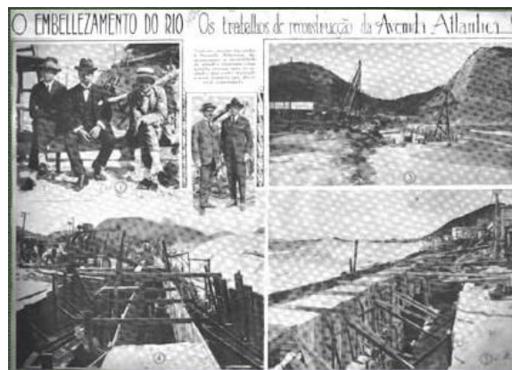
Imagem 47: Obras de reconstrução da Avenida Atlântica, c.1920. Revista da Semana. Coleção Elysis Belchior. Fonte: COSTA, Eliane (org.). Circuito Copacabana (CD Rom). Sonopress-Rimo. São Paulo, 2002.
