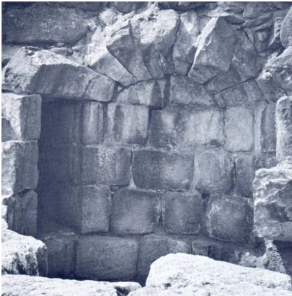
Imagem 2: Vista da cavidade do teatro romano em Beth Shean, possível local do vaso ressonador. Fonte: IZENOUR, George C.. Theater Design . McGraw-Hill Book Company. USA, 1977 (p.40).
