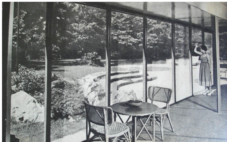
Figura 85 – “Anteparos de enrolar, de tecido plástico (vinil), cercam este terraço. Em poucos minutos podem ser enrolados como se fossem venezianas de janelas, desaparecendo completamente da vista. Assim, é possível manter o ambiente fechado ou aberto, conforme o tempo e em função da presença ou ausência dos enfadonhos insetos” (FRANCA, 1955, p. 21).
