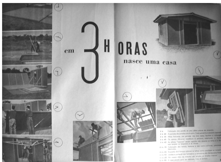
Figura 92 – Montagem de uma casa pré-fabricada (CASA E JARDIM, 1955, p. 08).
