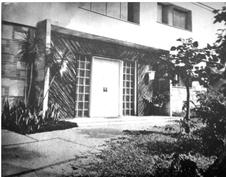
Figura 81 – Detalhe da fachada. Casa do arquiteto Henrique Alexander (CASA E JARDIM, n. 34, 1957, p. 14).
