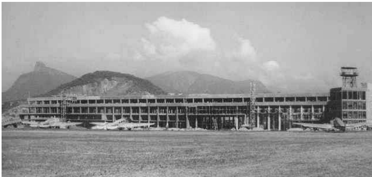
Fig.83: Foto da construção da estação de aviões.
