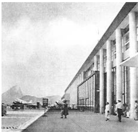
Fig.84: Fachada voltada para as pistas. Fonte: MINDLIN (1999:249)
