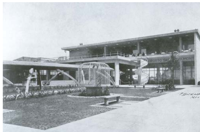
Fig.46: Estação de hidroaviões - fachada voltada para o mar. Fonte: Arquitetura e Urbanismo . p. 295, nov./dez. 1938.
