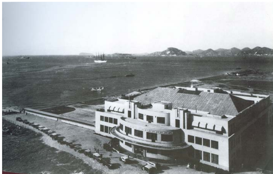
Fig.38: Estação de hidroaviões da PANAIR. Fonte: ARSA (1996:53)
