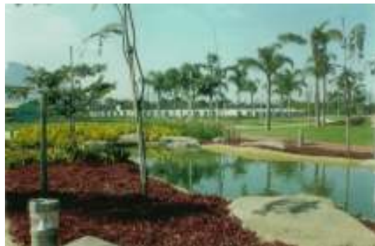
74. Lago construído em concreto armado, imitando formas de pedras naturais.
