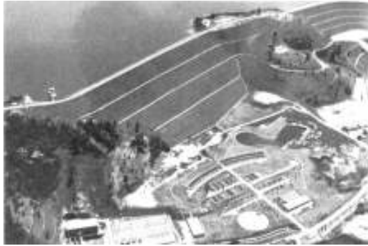
53. Usina hidrelétrica de Paraibuna e barragem de Paraitinga, SP, 1978. Arquitetura de João Rodolfo Stroeter e paisagismo de Fernando Chacel, Nina Jamra Tsukumo e Aziz Ab'Sáber.
