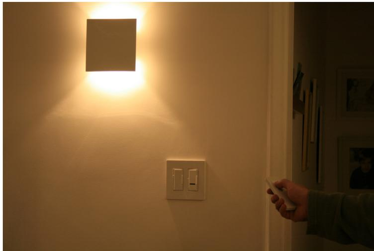
*Figura 66* – Detalhe dos comandos tipo maestro da Lutron. O controle da direita possui um receptor infravermelho para uso com controle remoto.
