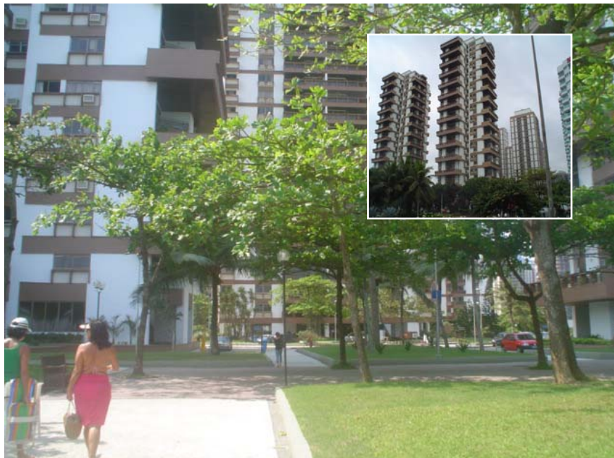
Condomínio Barramares – Av. Sernambetiba
