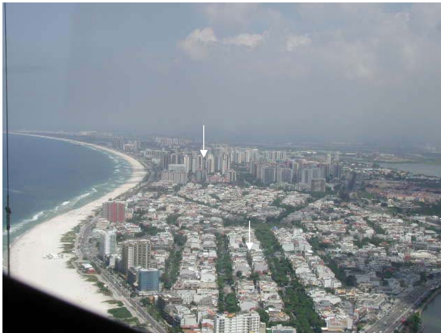
Em dois trechos do bairro: a implantação urbana no Jardim Oceânico em contraste com a alta densidade demográfica no Bosque Marapendi. Fonte: Aurélio Nogueira
