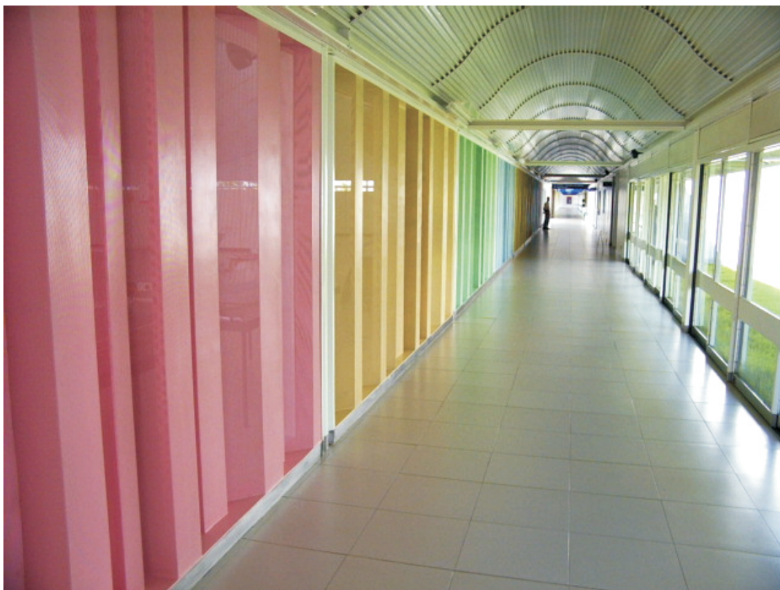
Figura 44 - Circulação do Centro de Reabilitação da Rede Sarah, Rio de Janeiro. A parede lateral em chapa metálica perfurada, com pintura em diversas cores; permitindo a privacidade aos ambientes sem estabelecer um completo fechamento aos espaços internos. Fonte: Espaço Saúde, 2003.
