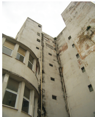
Figura 62 - Vista da Fachada Lateral do Hospital Municipal de Reabilitação. Fonte: Espaço Saúde, 2003.
