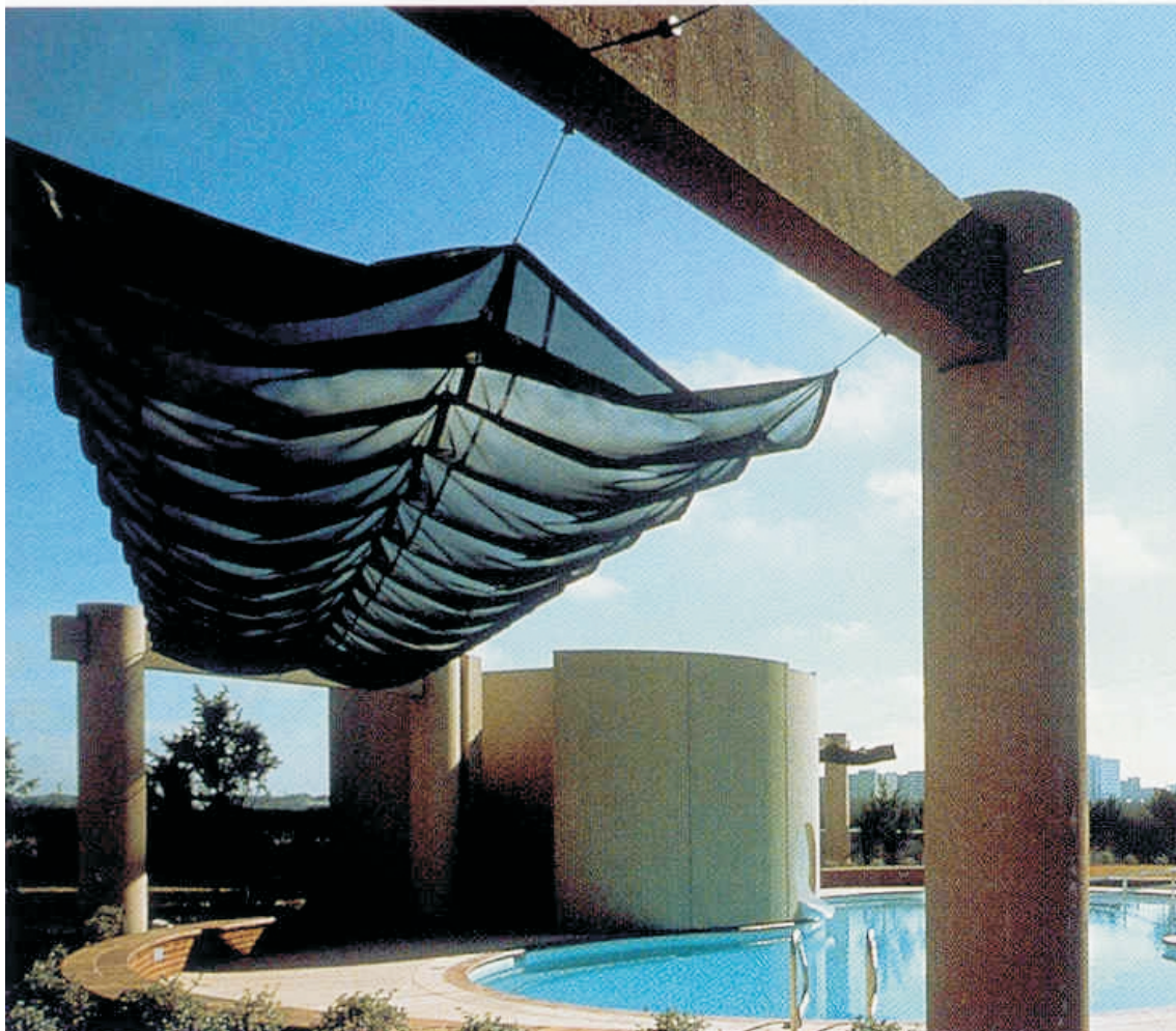
Figura 56 - Warm Springs Rehabilitation Hospital, San Antonio, Texas – Estados Unidos. Fonte: HKS Inc., 1999.
