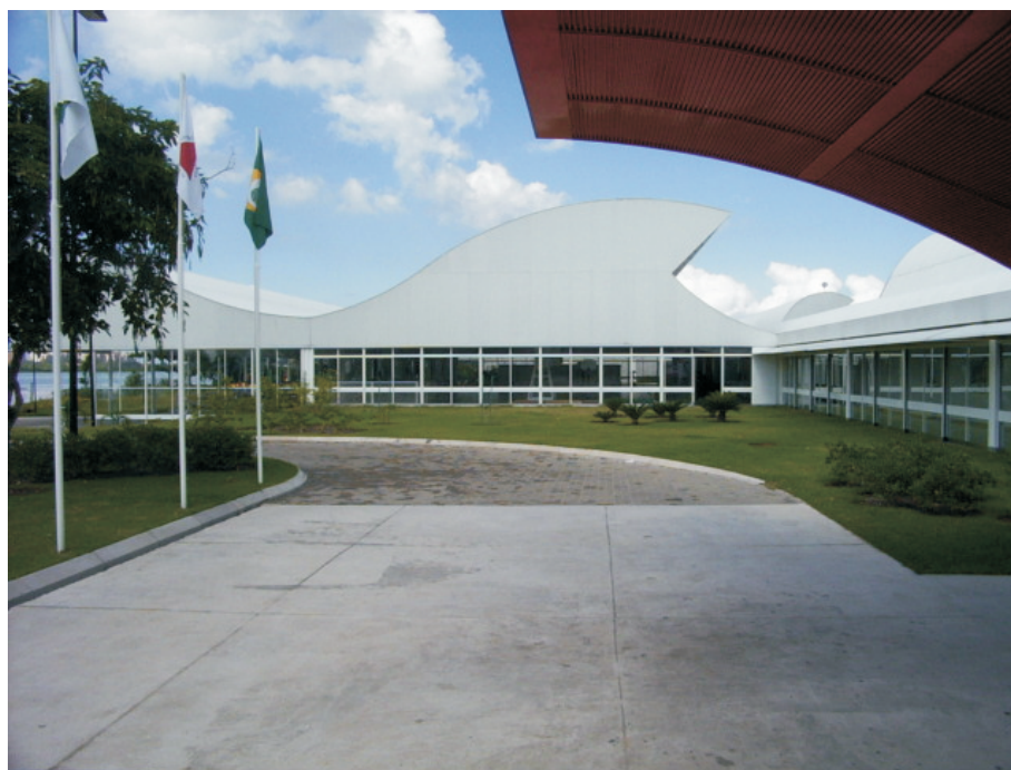
Figura 58 - Detalhe da cobertura de chegada do Centro de Reabilitação da Rede Sarah-Rio. Fonte: o autor, 2003.
