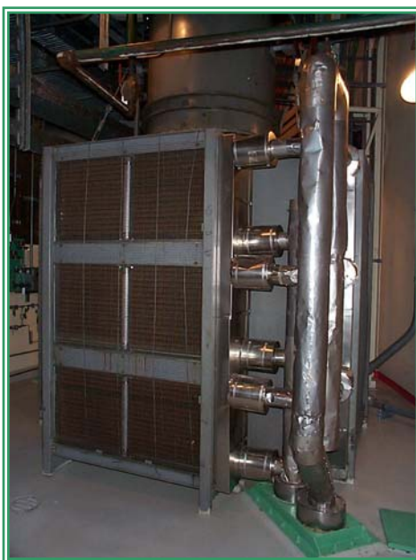
Ilustração 30 – Fan Coil
