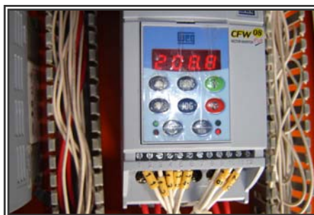
Ilustração 82- Inversor de frequência – velocidade 208,8 rpm
