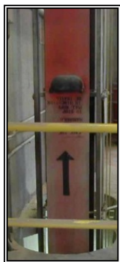
Ilustração 101 – Elevador tipo “ man lift ” Fonte: www.health.state.ok.us Maio, 2007
