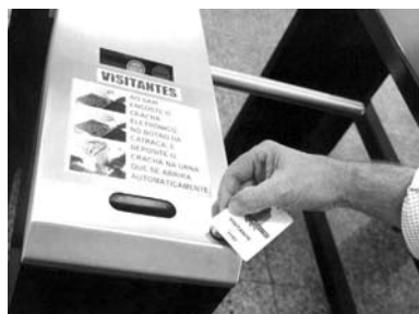
Ilustração 71 - Cartão de proximidade e cartão com tarja magnética para acesso através de catracas eletrônicas.
