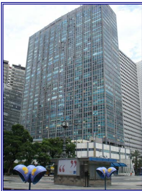
Ilustração 13 – Edifício Avenida Central Fonte: Arquivo do autor dezembro 2005
