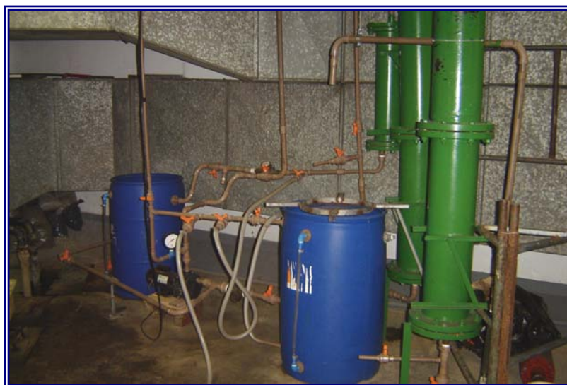
Ilustração 106 – Sistema final de filtração e separação. Fonte: Arquivo do autor – Maio, 2007.
