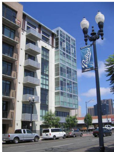
Figura 81 Island Street nas proximidades do Gaslamp – edifícios residenciais substituem galpões e armazéns
