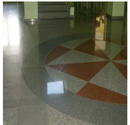
Fig. 62 – Detalhe do piso de granito do Hall de Entrada (foto da autora 2007)
