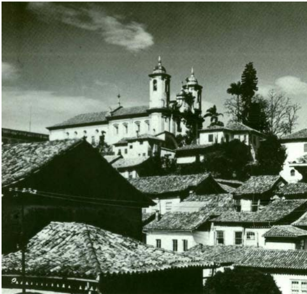
Fig. 221 – Igreja no topo do morro com acessos construídos
