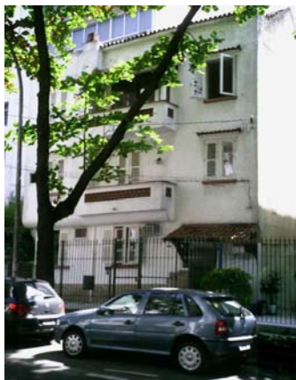
Ilustração 27 - Prédio totalmente vazio na Rua João Lira, 149 (preservado pelo decreto 20.300/01). Foto do autor: 16/11/2007
