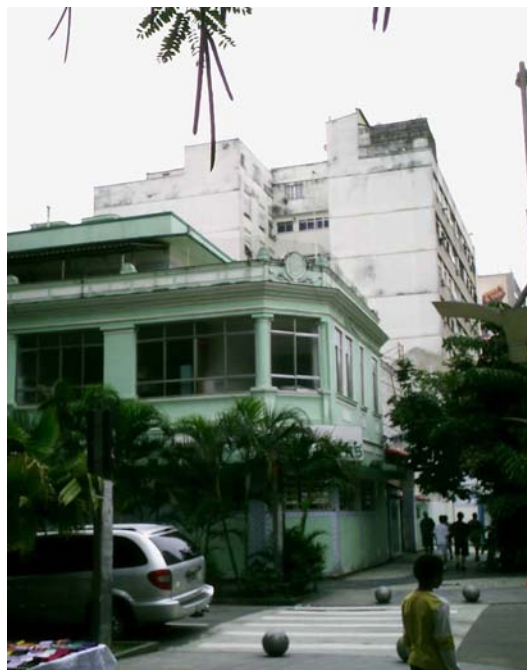
Ilustração 40. Avenida Ataulfo de Paiva, 658 - preservado pelo Dec. 20.300/01. Fonte: foto do autor, out/2007.
