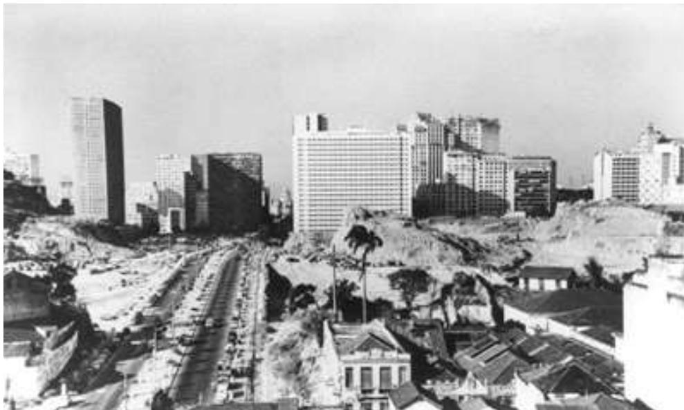
Ilustração 12. Avenida Chile após a demolição do Morro de Santo Antônio, década de 1950. Fonte: www.exposicoesvirtuais.arquivonacional.gov.br , acessado em 02/01/2008.
