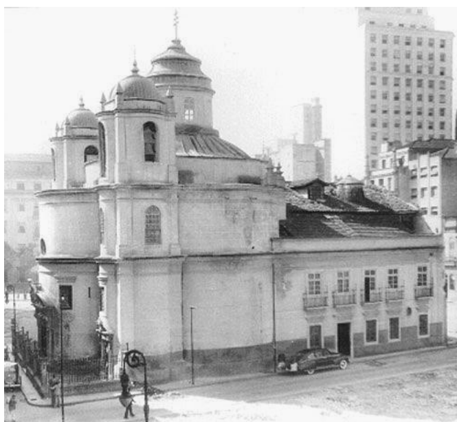
Ilustração 18. Igreja São Pedro dos Clérigos, demolida com a abertura da Avenida Presidente Vargas.
