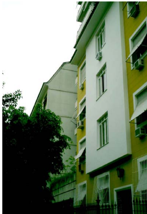
Ilustração 37 - Prédio preservado na R. Aristides Espíndola, 59. Foto do autor: set/2007.
