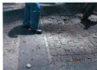
FOTO 3; MUDANÇA NO TIPO DE PAVIMENTO. TRANSIÇÃO ENTRE A CALÇADA DA RUA 1º DE MARÇO (PEDRA PORTUGUESA) E A RUA DO ROSÁRIO (PARALELEPÍPEDOS). A LIGAÇÃO ENTRE OS PAVIMENTOS É FEITO POR UMA PEÇA ÚNICA DE PEDRA
