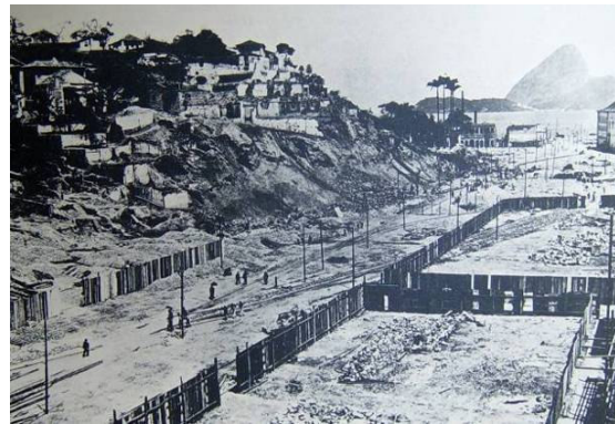
Fig. 32 – Construção da Av. Rio Branco, 1904
