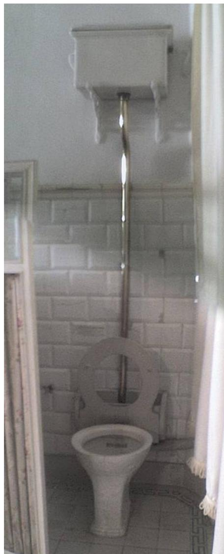
**Ilustração 73** – (ao lado) Vaso sanitário de procedência inglesa, com caixa de descarga suspensa; banheiro contíguo ao quarto de Ruy Barbosa, Fundação Casa de Ruy Barbosa. Fotografia da autora.
