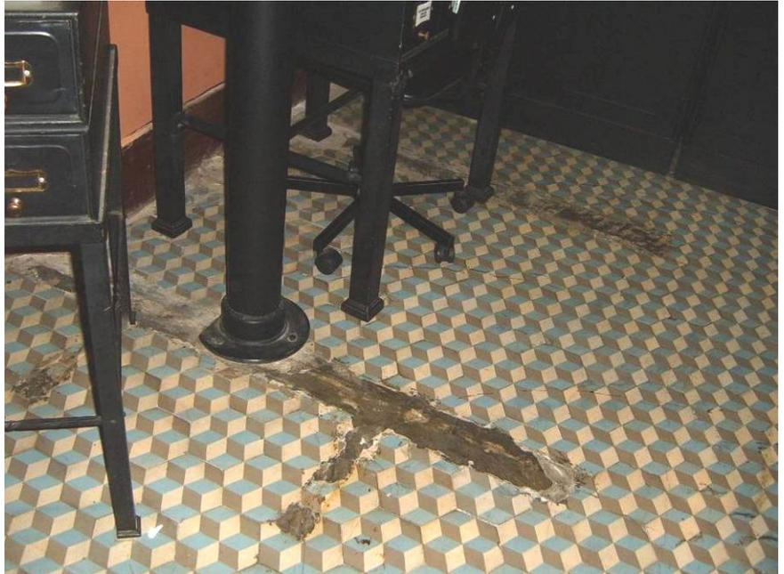
**Ilustração 70** – Detalhe de trecho do piso em ladrilho hidráulico original, com marcação de alvenarias demolidas, sugerindo a existência de pequeno cubículo para vaso sanitário e pia lateral, no salão da atual Seção de Iconografia da Biblioteca Nacional (pavimento de acesso da Avenida Rio Branco, salão voltado para a Rua México). Fotografia da autora.
