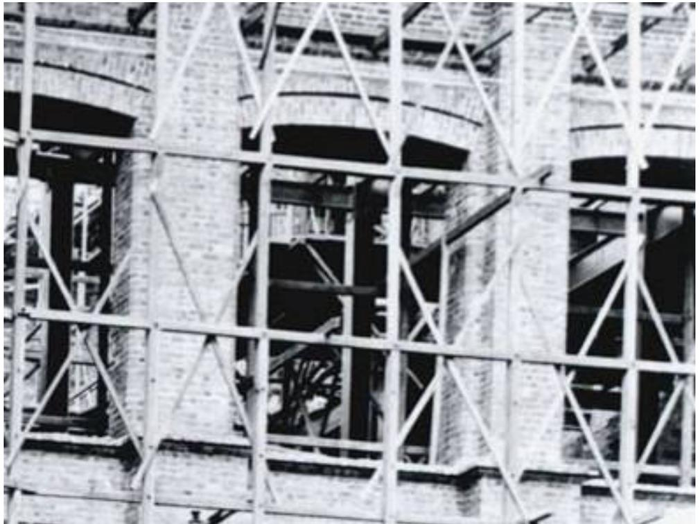
**Ilustração 51** – Detalhe da execução da alvenaria da fachada da Avenida, vendo-se os arcos de descarga montados com tijolos.(Álbum da Construção, sem data, cerca de 1906/1907. Seção de Iconografia – FBN).
