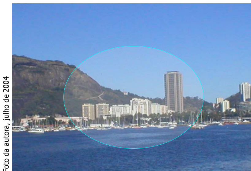
Figura 1.2: O conjunto, com o Rio Sul, visto da Enseada de Botafogo
