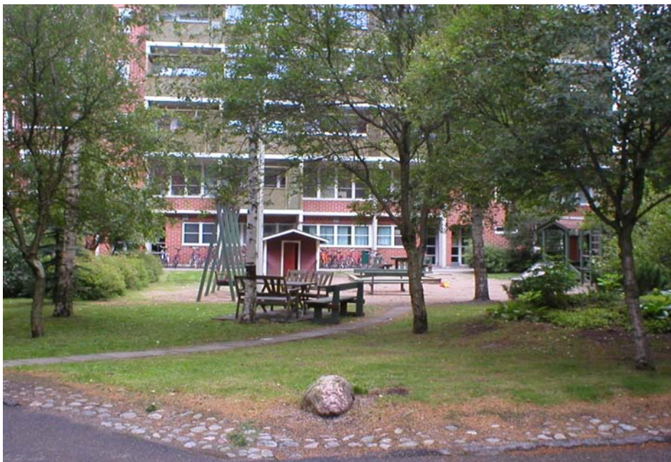
Figura 2.6: Pátio menor, no interior de uma das quadras que compõem o grande projeto de Päsila, em Helsinki.
