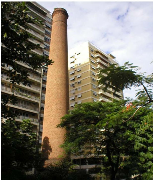
Figura 3.3: Chaminé no interior da praça, hoje
