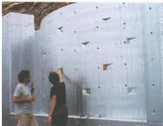
Fig. 50 Utilização de elementos refletivos inseridos diretamente no muro de contenção da via. Projeto da Via Perimetral Ocidental de Ymittos, Atenas, 2004.
