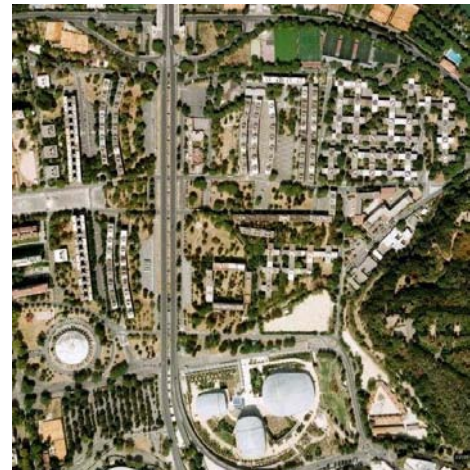
Fig. 35 Relação entre viaduto e tecido urbano. Villaggio Olimpico, Roma, 1960.
