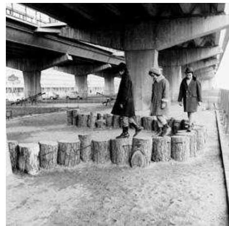
Fig. 36 Relação entre viaduto e tecido urbano. Villaggio Olimpico, Roma, 1960.
