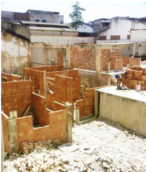
FOTOGRAFIA 60 – Construções em um dos pátios internos em 24 fev. 2007 FONTE: Arquivo Pessoal; AUTORIA: Monica Botkay.
