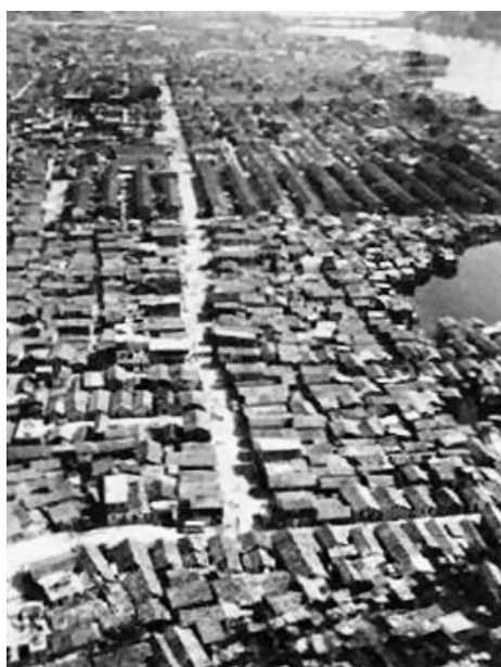
FOTOGRAFIA 13 – Vista aérea da Rua Principal do CHP da Nova Holanda.
