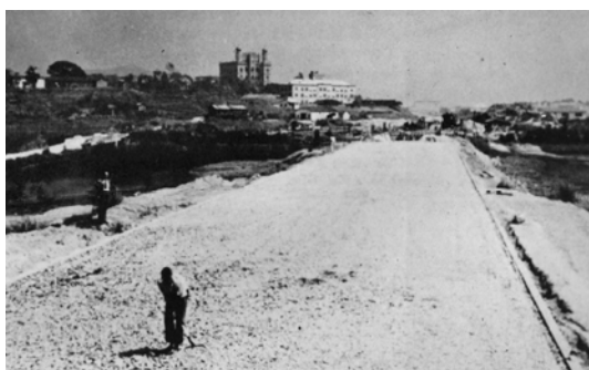
FOTOGRAFIA 04 – Construção da Avenida Brasil em 1940. FONTE: PREFEITURA DO RIO ET AL., 1992, p. 98. AUTORIA: desconhecida.
