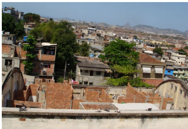
FOTOGRAFIA 59 - Vista do terraço para um dos pátios internos set. 2007 FONTE: Arquivo Pessoal; AUTORIA: Carolina Barrozo P. Torres.
