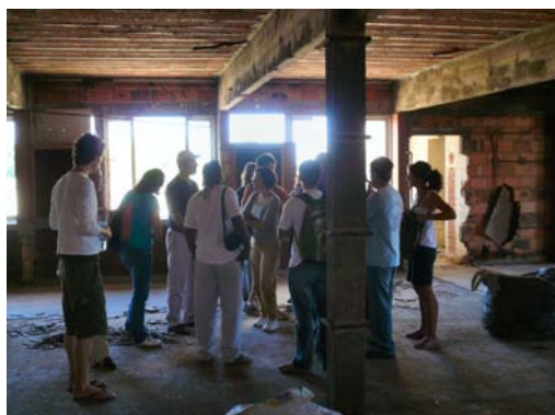
FOTOGRAFIA 40 – Terceiro andar do edifício: ainda está sendo realizada a limpeza para a retirada de entulho. FONTE: Arquivo Pessoal. AUTORIA: Carolina Barrozo Torres, 24 ago. 2007.
