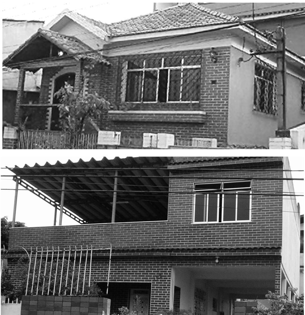
Figura 27: Residências 1 e 5, com aplicação de “tijolinhos” de revestimento apenas nas fachadas frontais
