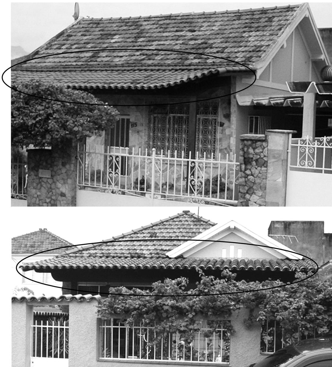
Figura 30: Residências 7 e 8, com telhados colocados a frente da casa original, criando assim uma nova varanda
