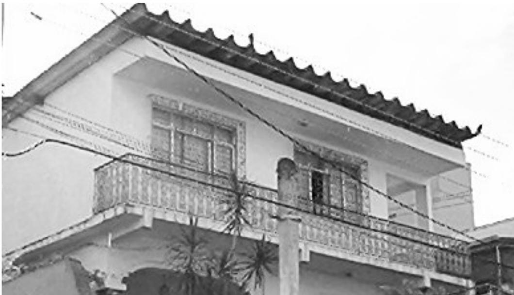
Figura 26: Residência 3, 5 e 6: fachadas com janelas de alumínio e telhas de amianto
