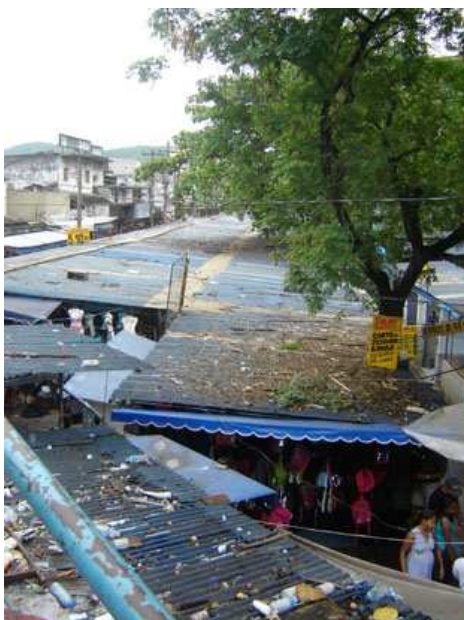
Figura 91: Camelódromo sob a Estação do Mercado de Madureira.
