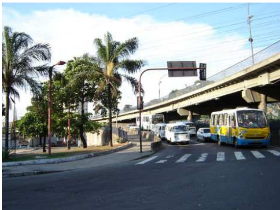
Figura 81: Trânsito sob o Viaduto Negrão de Lima. Fonte: Foto Mariana Vieira. Madureira, 2008.
