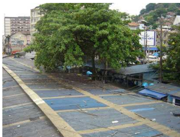
Figura 92: Cobertura do camelódromo localizado sob a Estação Mercado de Madureira.
