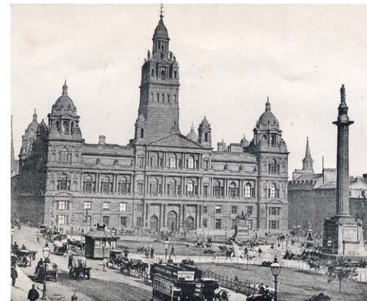
| Fig. 159 | Edifício do governo municipal, construído entre 1883 e 1887.
