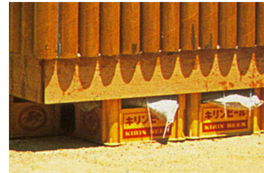
[Fig. 51] Engradados funcionam como base estrutural para as estruturas temporárias de papelão.
