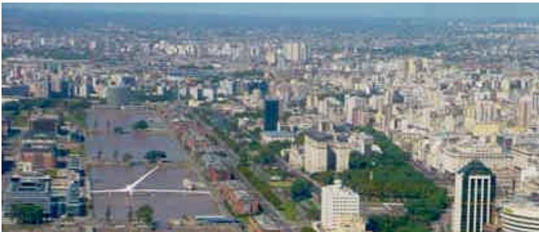
FIGURA 28 Vista panorâmica do centro de Buenos Aires. Fonte: http://img.diariodelviajero.com/2008/01/puerto-madero-1.jpg . 01 jun. 2008.
