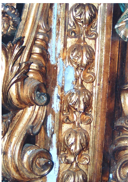
Fig. 90 – Consolidação do suporte no painel lateral ao altar capela Foto: RG – Conservação e restauração
