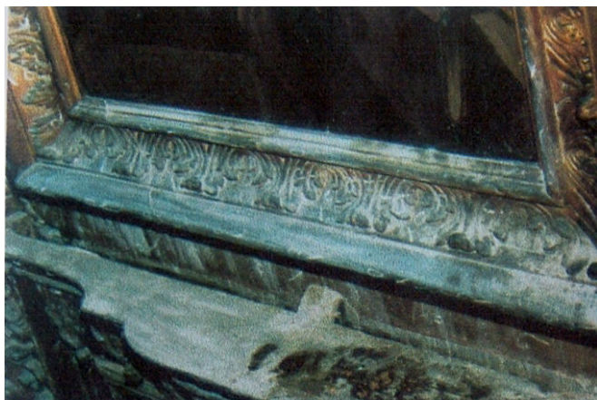
Fig. 81 – Detalhe da Moldura do painel lateral esquerdo com material particulado (sujidade) Fonte: Projeto RG – Conservação e Restauração/Fazendo Arte
