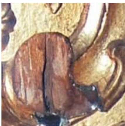
Fig. 49 – Parte faltante no ornato com perda de suporte (fratura) Capela Nossa Senhora da Conceição Fonte: RG – Conservação e restauração.
