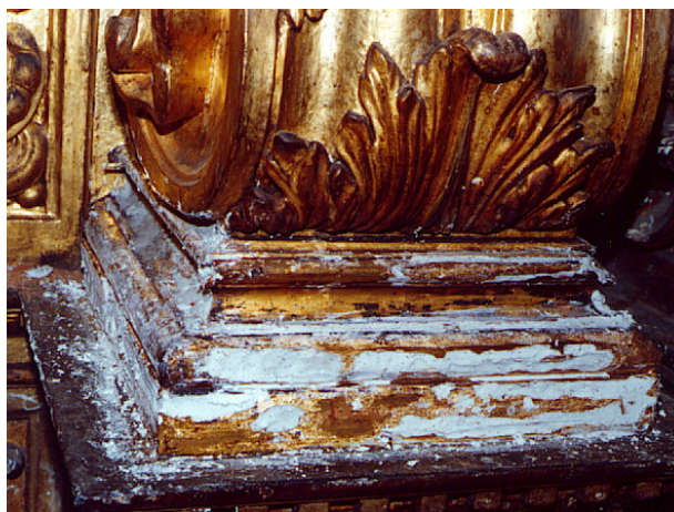
Fig. 54 – Consolidação da talha do altar Fonte: MONTALVO, 2008.
