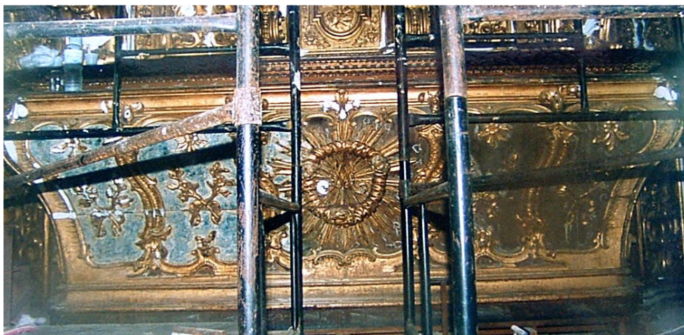
Fig. 89 – Retirada de repinturas na mesa do altar Fonte: RG – Conservação/Restauração/Fazendo Arte
