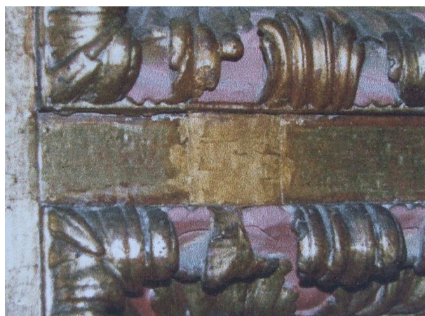
Fig. 50 – Moldura de talha da nave central. Irregularidade no retoque do douramento – Mosteiro de São Bento no Rio de Janeiro. Fonte: REGIS, 2000.
