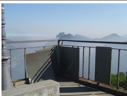
Fig. 78- Guarda-corpo no Estacionamento: corrosão na estrutura metálica e placas metálicas soltas
