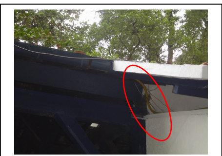
Fig.60- Plataforma da Estação Inicial: Fiação Exposta.
