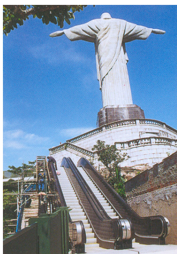
Figuras 40, 41 e 42 – 2ª etapa do projeto Cristo Redentor: instalação de escadas rolantes e de elevadores. Fonte: FUNDAÇÃO ROBERTO MARINHO, 2005.
