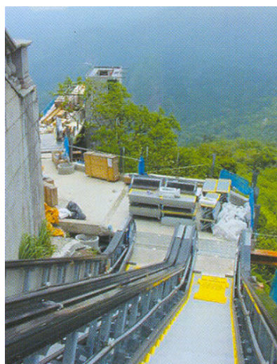
Figuras 40, 41 e 42 – 2ª etapa do projeto Cristo Redentor: instalação de escadas rolantes e de elevadores. Fonte: FUNDAÇÃO ROBERTO MARINHO, 2005.
