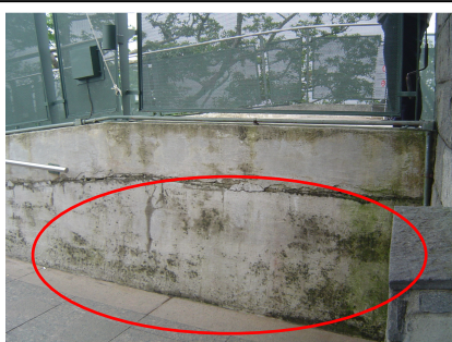
Fig.85 – Passarela: manchamentos pela presença de umidade (microflora).
