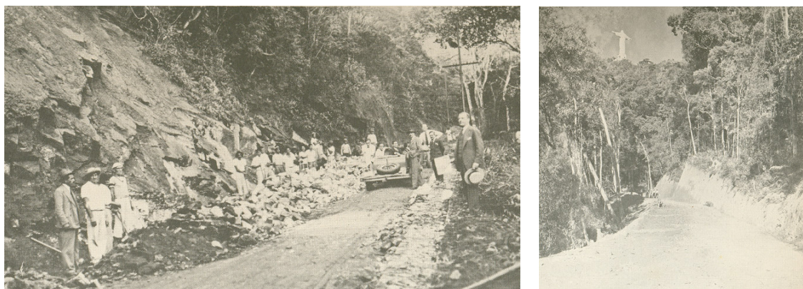
Figuras 28 e 29 – Construção da estrada Paineiras-Corcovado. Fonte: FIGUEIREDO, 1981.
