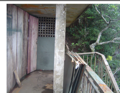
Fig. 77 – Área de mirante: inadequação de uso e degradação dos elementos: estruturas metálicas, alvenaria e piso.
