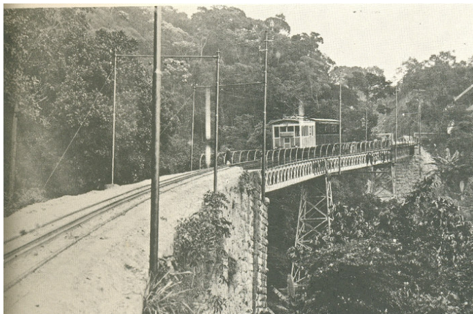
Figura 18 – Antigo trem da “Light” atravessa o Viaduto do Silvestre. Fonte: SEMENOVITCH, 1997.
