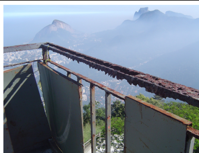
Fig. 78- Guarda-corpo no Estacionamento: corrosão na estrutura metálica e placas metálicas soltas
