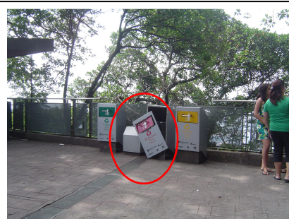
Fig. 76 – Área dos Elevadores: coletores seletivos danificados.
