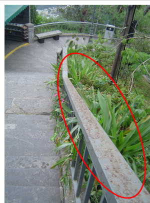
Fig.88 – Escadaria: corrosão do corrimão metálico.
