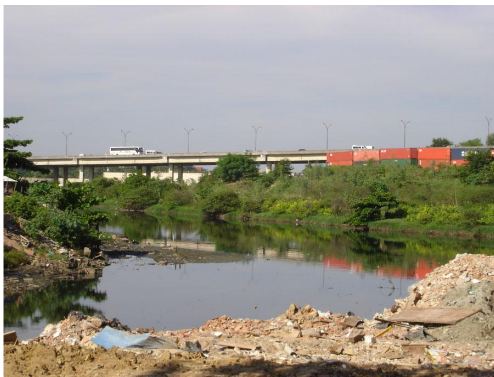
Figura 6. 17 Vista da Baía de Guanabara a partir do Conjunto Esperança, com a Estação de Tratamento de Esgoto Alegria e Linha Vermelha ao fundo.
