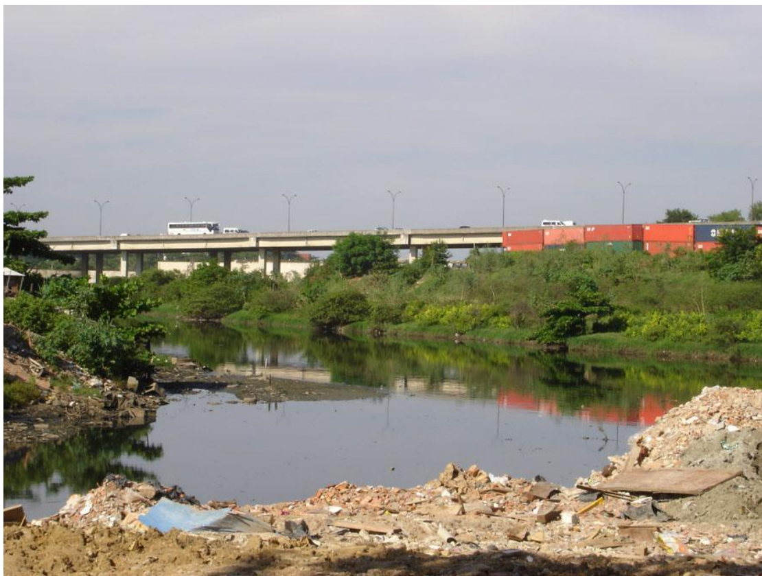
Figura 6. 31 Beira do Canal do Cunha com vista para a Linha Vermelha e muro branco da ETE Alegria.
