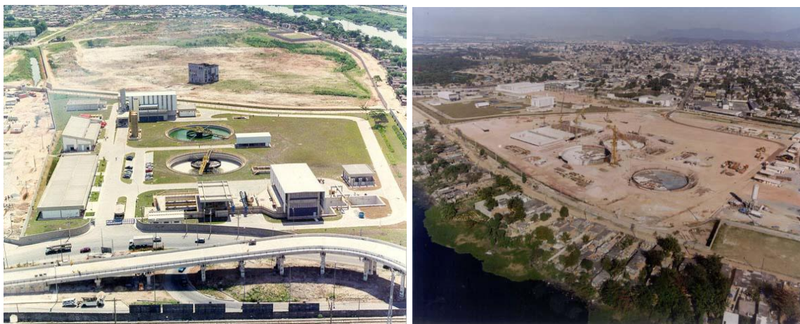
Figura 5. 8 Vistas da Estação de Tratamento de Esgotos Pavuna, junto ao Rio Pavuna (AQUACON).
