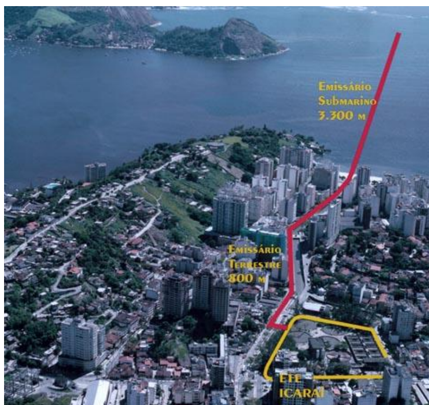
Figura 6. 21 ETE Icaraí - Estação de tratamento de esgotos, em funcionamento, atende 230 mil habitantes do município de Niterói. (SEMADUR).
