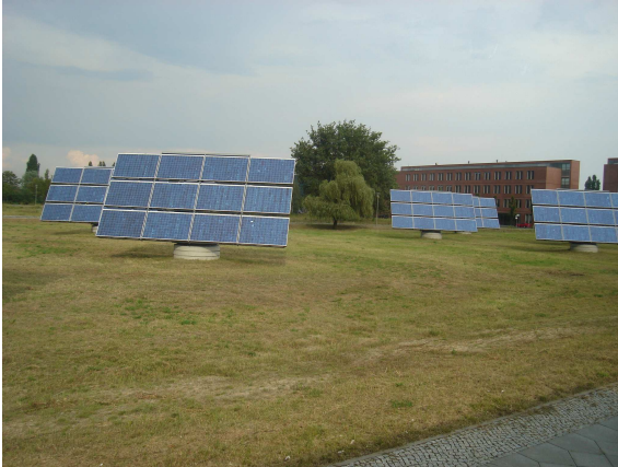
Imagem 16 – Painéis de energia solar em Berlim que seguem a movimentação do sol. (Fotos do autor/2007)
