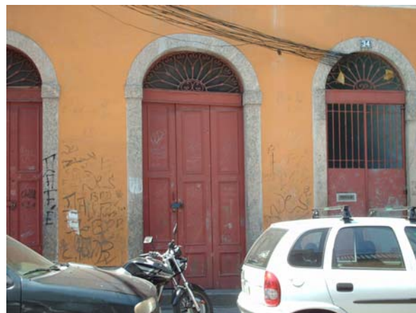
Figura 39 – Imóvel na Rua Senador Pompeu, 34. Adaptação no sistema de calhas, na esquerda e na instalação de telefones, na direita. Fotos do autor, 2008.
