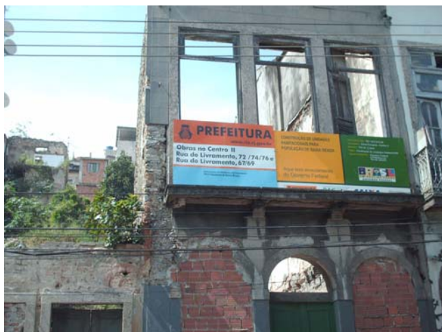
Figura 43 – Imóvel na Rua do Livramento, 69. Estado atual. Foto do autor, 2008.
