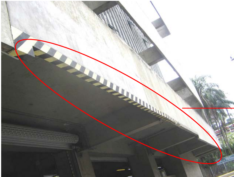
FOTO 16 – Entrada de veículos: necessidade de corte em viga estrutural FONTE: arquivo da pesquisadora. Novembro/2007
