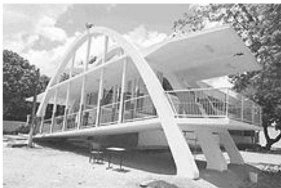
FIGURA 12 - Escola Rural Alberto Torres.Foto. FONTE: Revista Arquitetura no 13, Julho de 1963.
