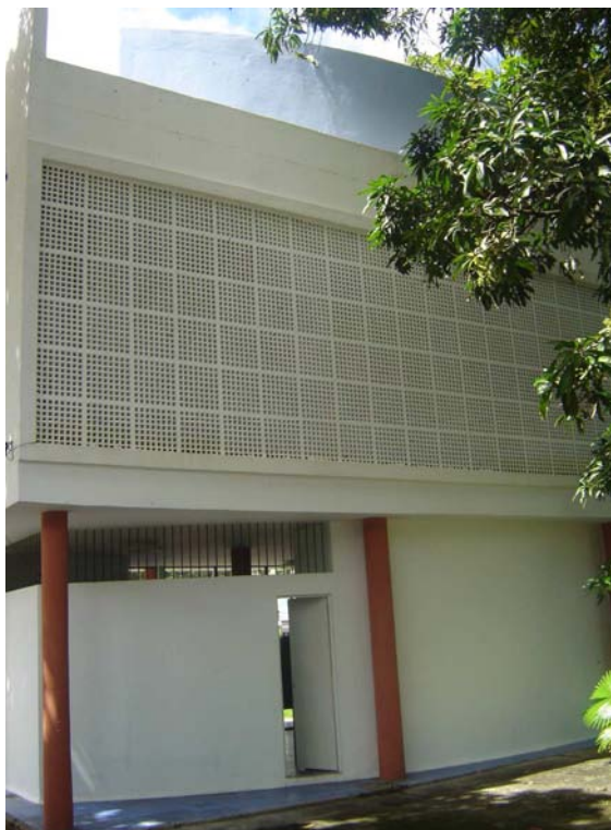
FIGURA 28 - IAB - PE, recentemente restaurado. Foto: Detalhe da fachada de Fundos. Elisa Fonseca Nascimento, 2006.
