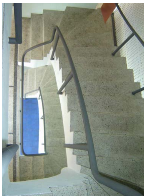
FIGURA 27 - IAB - PE, recentemente restaurado. Foto: Escada no hall de acesso. FONTE: Elisa Fonseca Nascimento, 2006.
