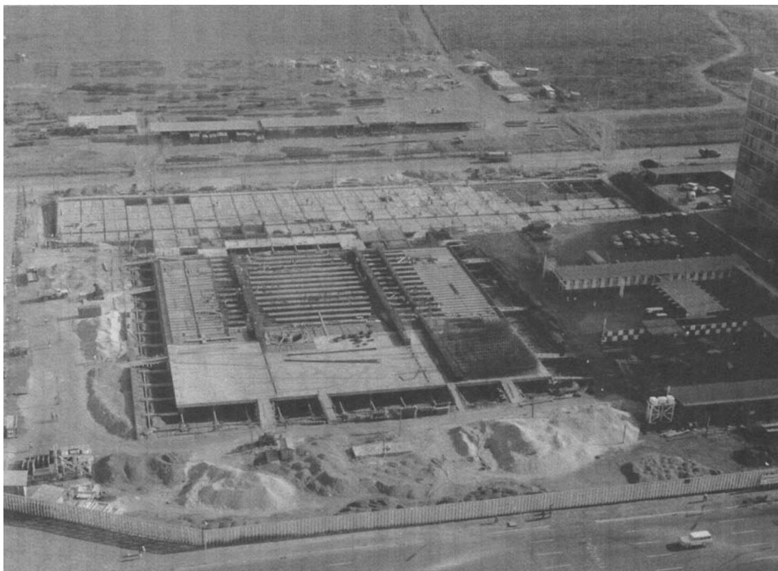
FIGURA 59 - Imagem da construção do Palácio do Itamaraty, mostrando o "esqueleto" do edifício. Foto cedida por Milton Ramos.
