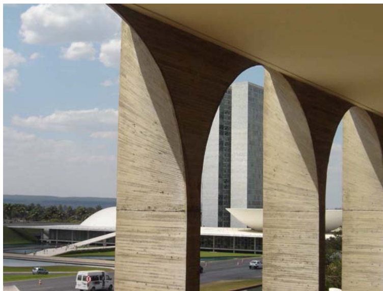
FIGURA 58 – Palácio dos Arcos - Detalhe da curvatura dos arcos e da textura impressa no concreto pelas pequenas ripas das formas. FONTE: Elisa Fonseca Nascimento, 2006.
