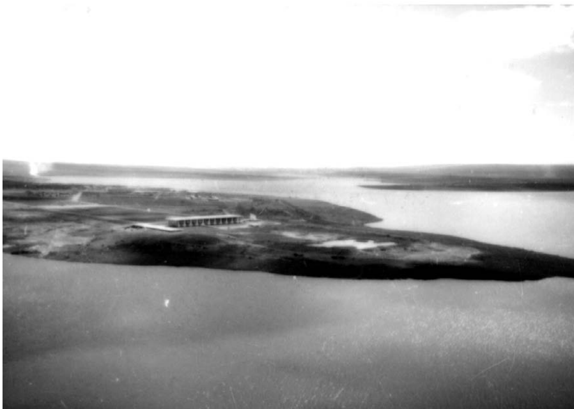
FIGURA 40 - Imagem do começo da construção de Brasília. FONTE: Arquivo Público do Distrito Federal.
