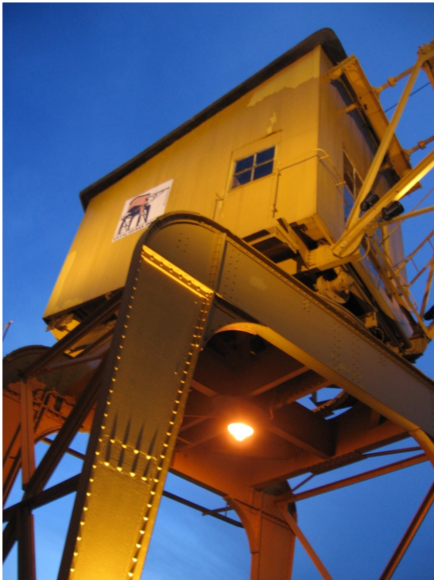
Guindaste da Estação das Docas, em Belém do Pará. Fonte: o autor, 2007.
