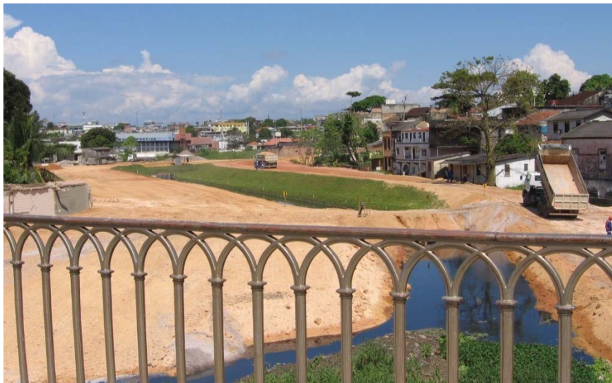
Igarapé dos Educandos em Manaus, antes e durante as obras do PROSAMIM. Fonte: o autor, 2007.
