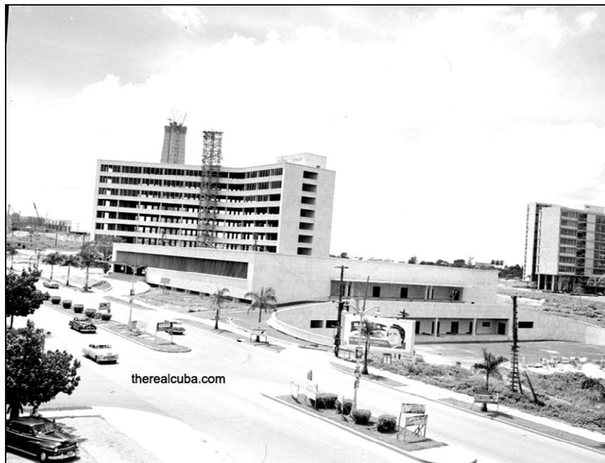
Figura 71. Conjunto da Plaza Cívica em construção, Havana anos 1950. Fonte: therealcuba.com
