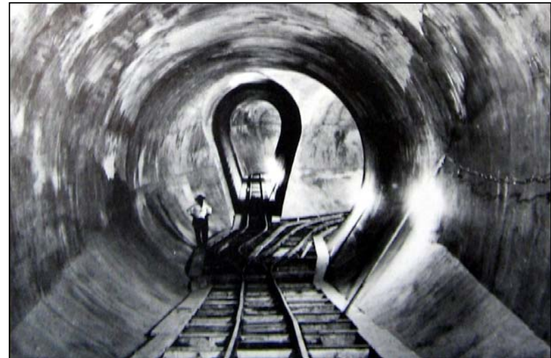
Figura 10. Nova adutora do Guandu, túnel de 43 quilômetros que resolveu o sério problema da água na Guanabara. Fonte: LACERDA, C., 1987.
