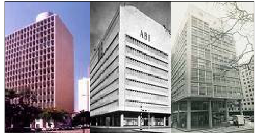
Figura 53. Edifício do MEC, 1936 (esquerda), da ABI, 1936 (médio) e do IRB, 1941 (direita), exemplos de aplicação dos princípios do Movimento Moderno.
