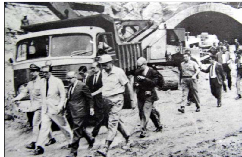
Figura 11. Lacerda visitando uma das galerias do Túnel Rebouças. Fonte: LACERDA, C., 1987.
