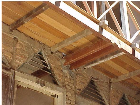
Fig.III.19 Estrutura de piso em madeira. Foto do autor, 2008.
