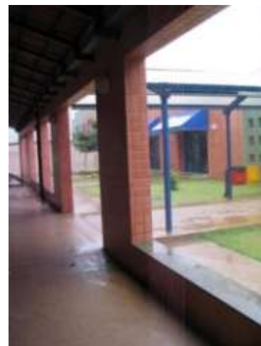
Fig.139- Água no piso da circulação Fig.140- Detalhe durante a chuva Fig.141- Ambiente com poças d'água
