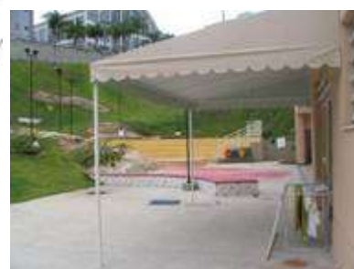
Fig.82 – Pátio Posterior: Mureta vermelha
