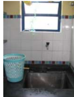
Fig.130- Detalhe do tanque
