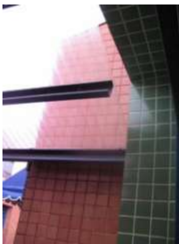
Fig.135- Detalhe da cobertura
