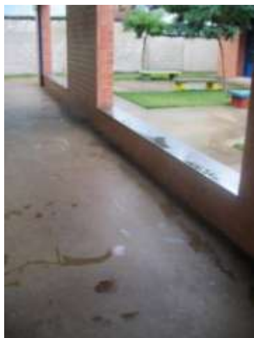
Fig.139- Água no piso da circulação Fig.140- Detalhe durante a chuva Fig.141- Ambiente com poças d'água
