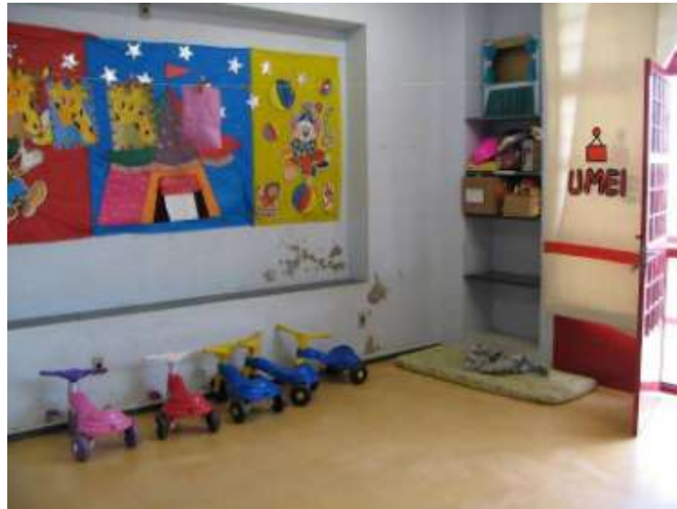
Fig.89- Sinais de infiltração no banheiro Fig.90- Sinais de infiltração na parede da sala de atividades
