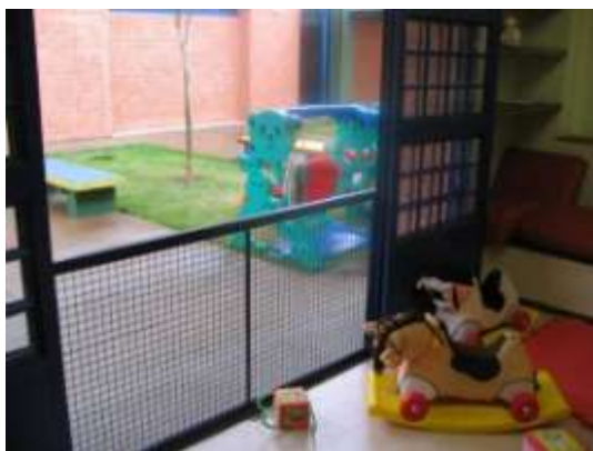
Fig.125- Detalhe porta de abrir da sala dos bebês
