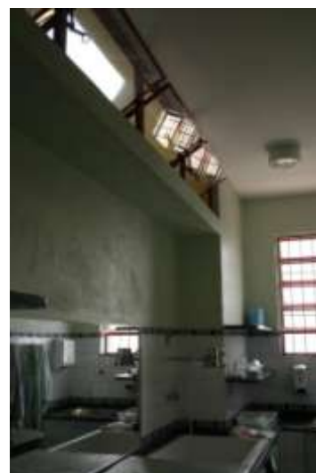
Fig.95- Detalhe das esquadrias
