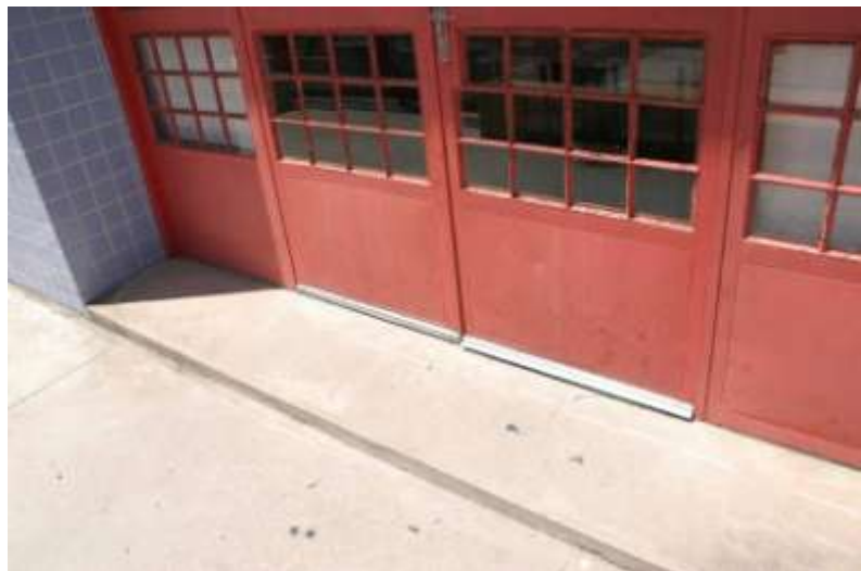
Fig.91- Chuveiro das crianças Fig.92- Aparato usado para evitar que água da chuva entre no ambiente
