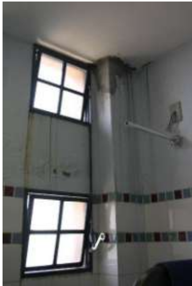
Fig.89- Sinais de infiltração no banheiro Fig.90- Sinais de infiltração na parede da sala de atividades
