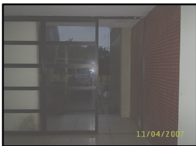
Ilustração70: Descarga com porta de correr.
