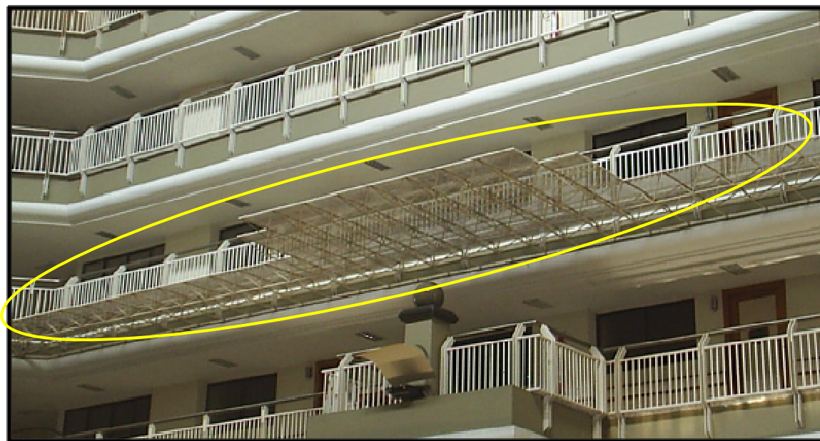
Ilustração 55: Bandeja de proteção para quedas de objetos.
