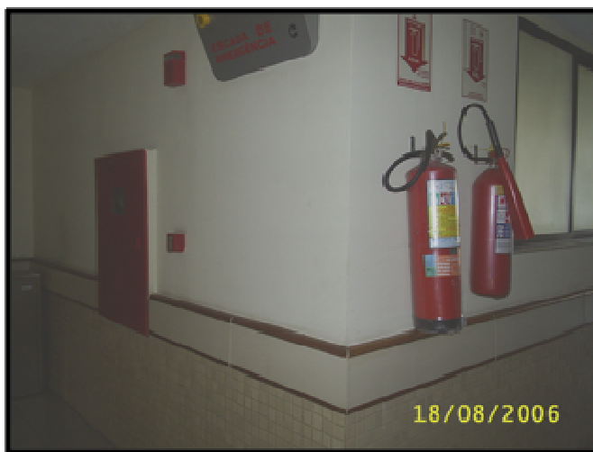
Ilustração 61: Sinalização da saída de emergência e canto vivo na mudança de direção.
