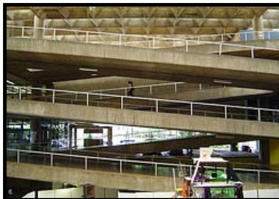
Ilustração 6: Vista das rampas de acesso aos andares.
