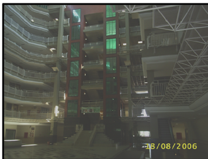
Ilustração 69: Escada não enclausurada com acesso pelo átrio.
