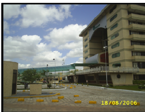
Ilustração 52: Acima, acesso da fachada posterior e abaixo, acesso da fachada principal.
