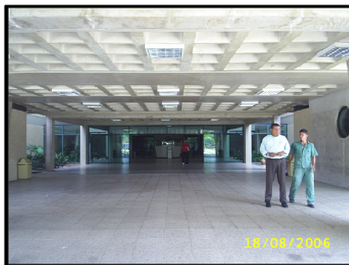
Ilustração 58: Vista do acesso ao vestíbulo do subterrâneo.
