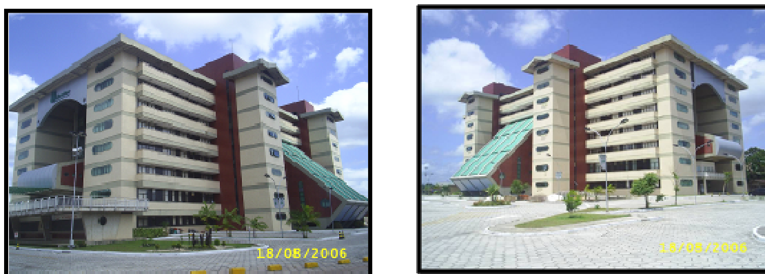
Ilustração 48: Vista da fachada do lateral e posterior do edifício UNAMA BR
