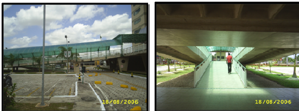
Ilustração 57: À esquerda, vista lateral da rampa de acesso. À direita, parte que se direciona ao subterrâneo
