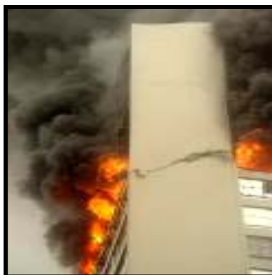
Ilustração 23: Incêndio na Sede da Eletrobrás, RJ.
