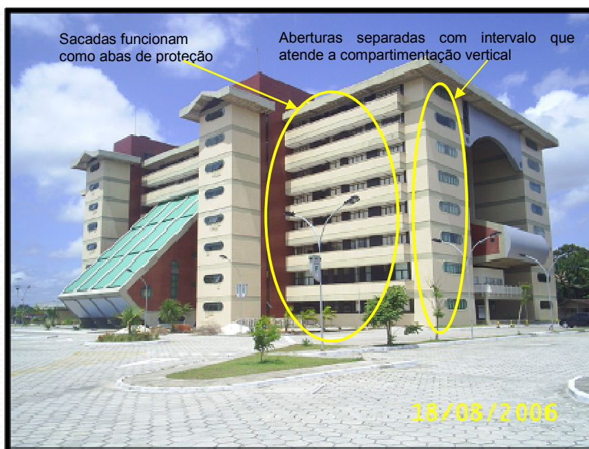
Ilustração 54: Vista externa posterior do edifício UNAMA BR.
