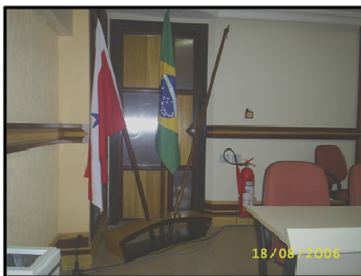
Ilustração 64: Bloqueio por mobiliário da saída do auditório do 1º pavimento.
