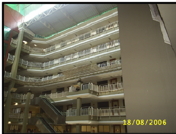
Ilustração 62: Guarda-corpo metálico vazado.
