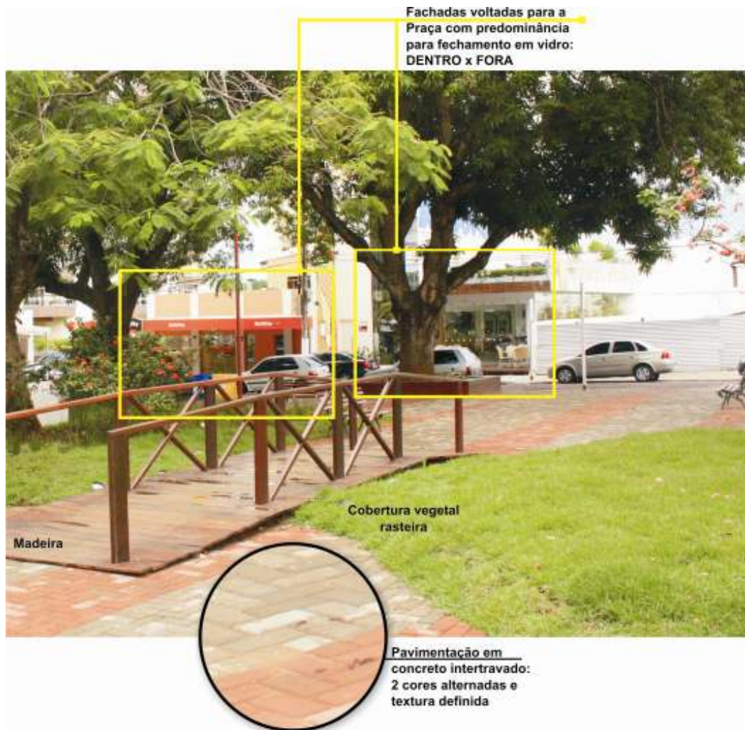
Figura 81. Tratamento Paisagístico - detalhe para a pavimentação em blocos de concreto intertravado. (Fonte: Bethânia Moura, 2009)
