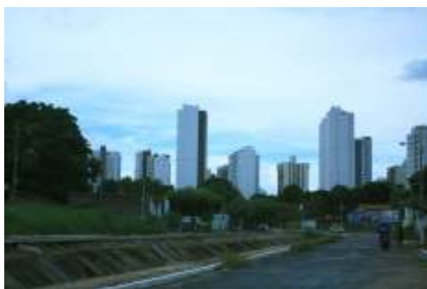
Figura 61. Vista Avenida Oito de Abril, córrego em vala.
