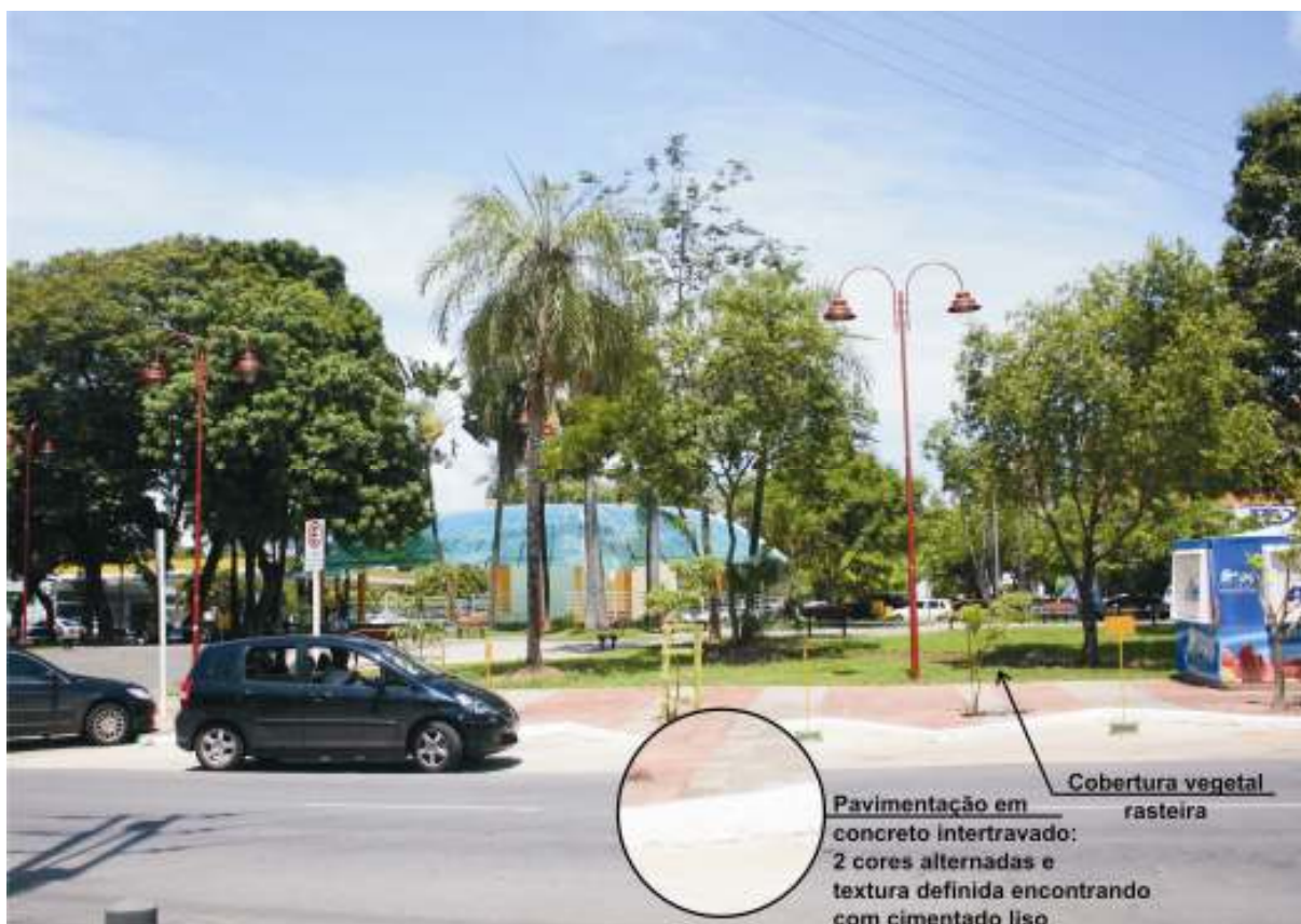
Figura 89. Tratamento Paisagístico - detalhe para a pavimentação em blocos intertravados de concreto em tres cores. (Fonte: Bethânia Moura, 2009)
