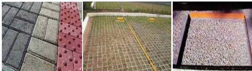
**Figura 47:** a. piso intertravado; b. blocos vazados; c. asfalto poroso; d. solo compactado (fonte: ARAÚJO; TUCCI, 2000).
