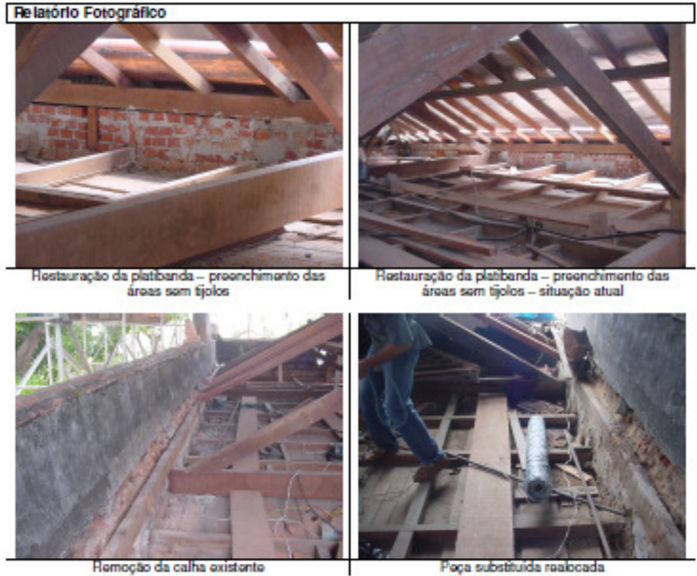
Figura 59: Relatório de obra do telhado da Garagem da Casa de Rui Barbosa, onde foram registrados todos os procedimentos executados, estes foram registrados em fotos, textos e em plantas, assim como as peças novas que foram inseridas e qualquer novo tipo de intervenção necessária para a consolidação do telhado. Fonte: Arquivo BK Arquitetos Associados LTDA.
