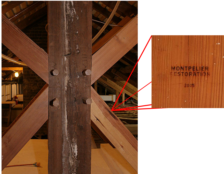
Figura 65: Exemplo de marcações feitas nas peças novas que substituíram as danificadas.
