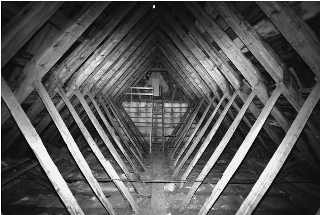
Fig. 20: Estrutura do telhado da Igreja Garda em Gotland, Suécia.
