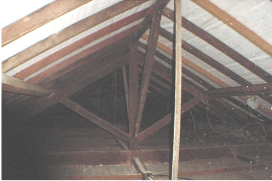
Fig. 12: Tesoura do telhado da garagem da Casa de Rui Barbosa.
