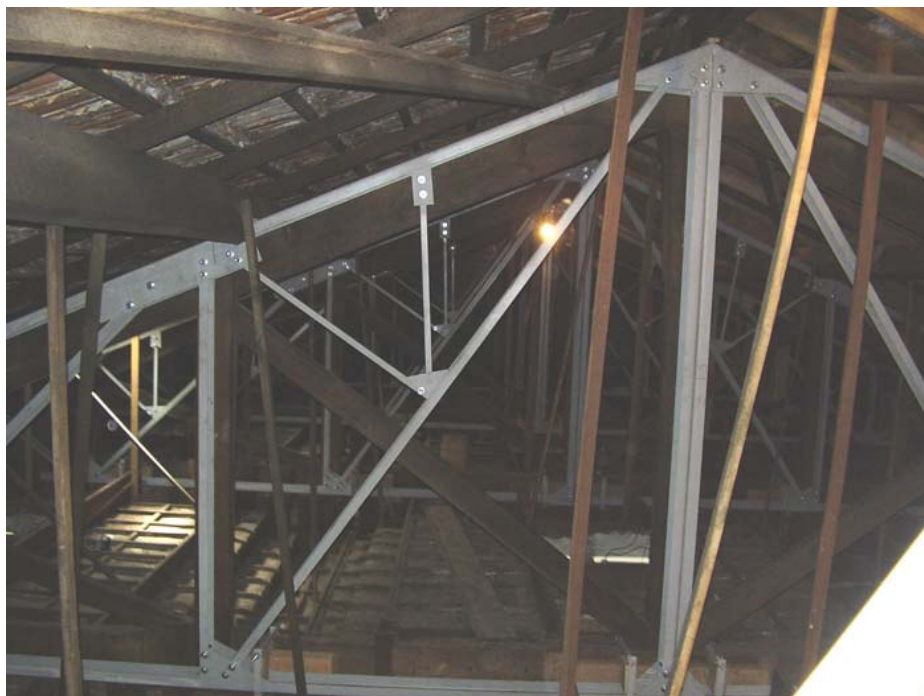
Figura 81: Situação após executado o projeto de restauração do telhado da Paróquia São Francisco de Paula onde foram executados reforços estruturais do telhado com estruturas metálicas sobreposta à estrutura de madeira existente. Fonte: http://www.albatroz.arq.br/site/obras/ , acessado em 25/06/2008.
