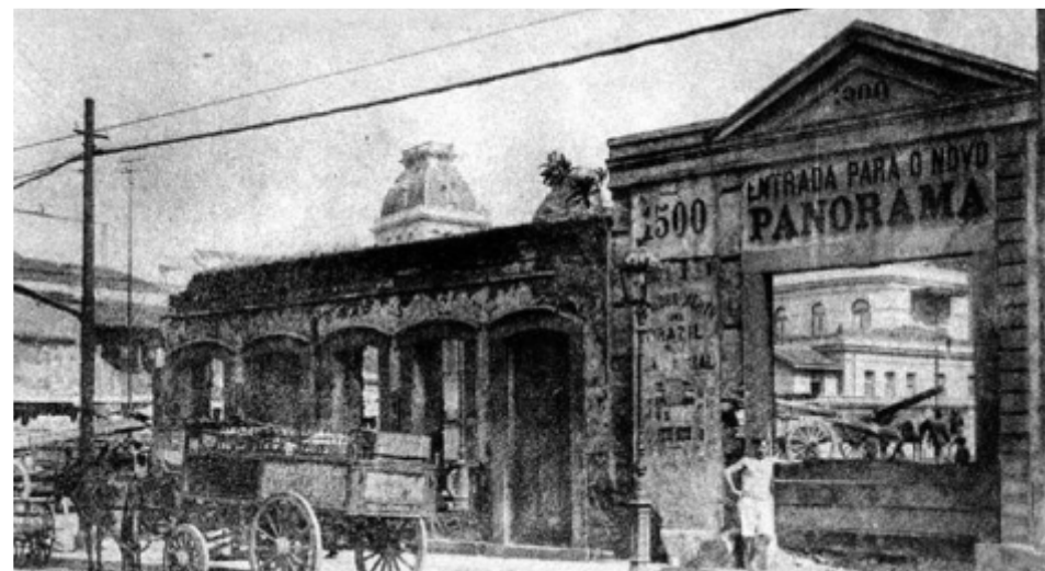
Fig.2- A entrada da nova rotunda de Victor Meirelles. Na foto em 1902, já em ruínas.
