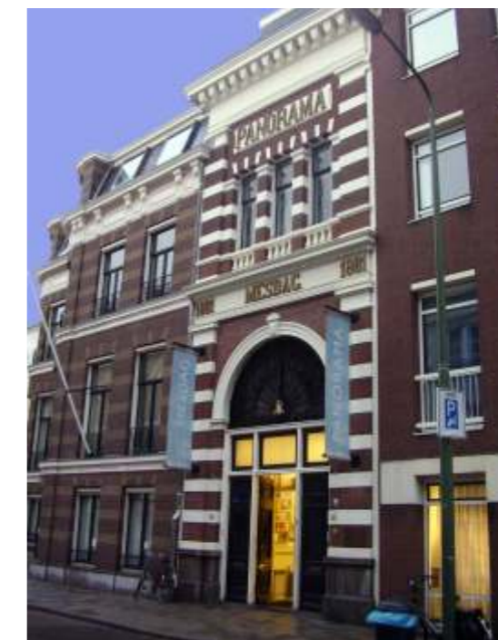
Fig.111- Fachada do edifício contíguo a rotunda.
