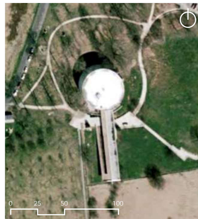
Fig.13- Vista superior do Ciclorama e edifício adjacente.
