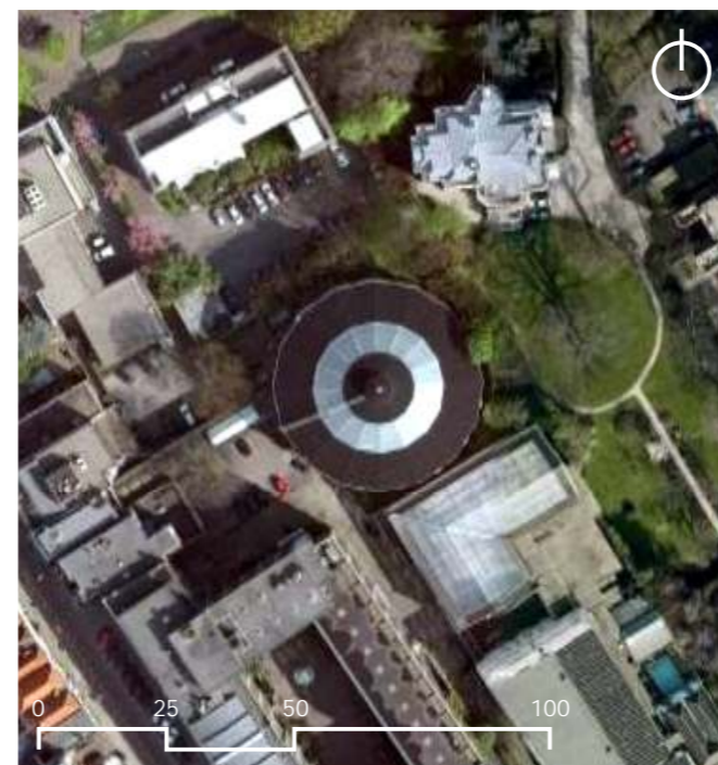
Fig.110- Vista superior da Rotunda e entorno imediato.
