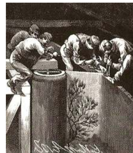
Fig.20- A montagem da tela na rotunda.
