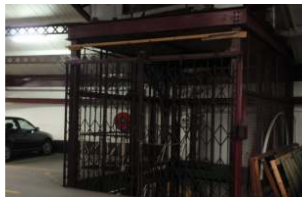
Fig.34- Elevador contruído após a reforma da rotunda.
