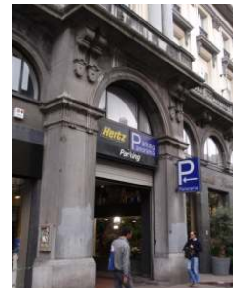
Fig. 18- Entrada do edifício.
