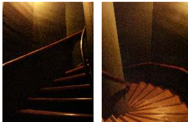
Fig.113 e 114- Escada helicoidal de acesso a plataforma.
