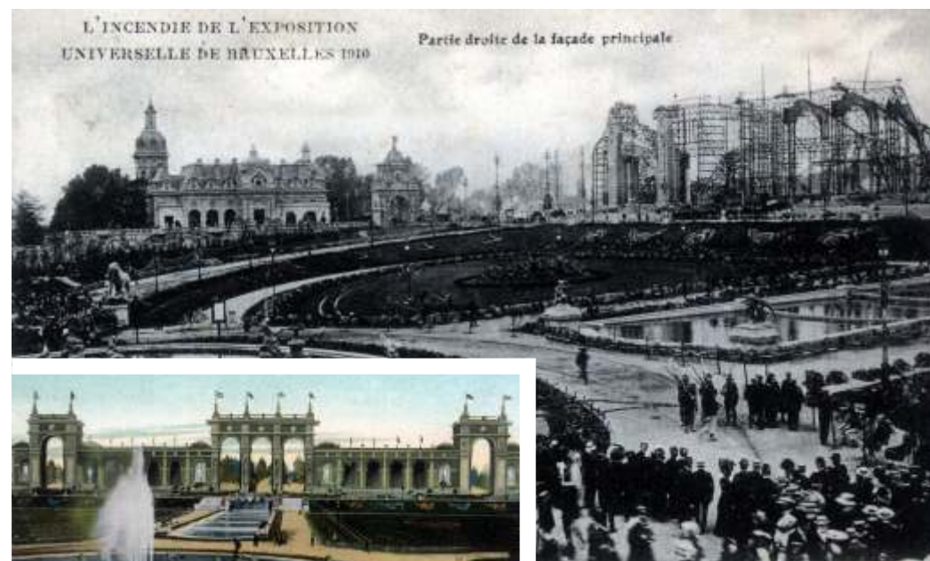
Fig.6 e 7- A Praça principal após o incêndio com a arcada destruída. Detalhe: a nova arcada.
