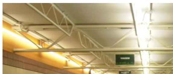
**Figura 29.** Detalhe lâmpadas fluorescentes T12 aplicadas diretamente na estrutura.
