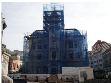
Figura 57: Antiga sede do museu em obras - 2008
