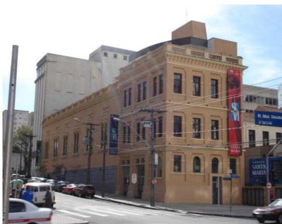
Figura 98- Capela Santa Maria e prédio de três pavimentos como entrada
