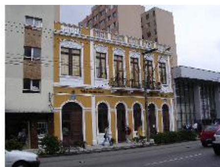
Figura 52: Casa dos Anjos primeira a ter liberação de TPC em etapas
