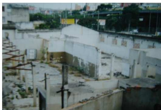
Figura 149: Vista interna do Conjunto Arquitetônico do Oiapoque em 2000
