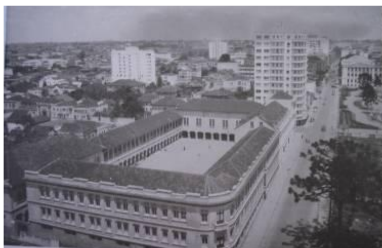
Figura 95: Conjunto de edificações do Colégio Santa Maria em 1944
