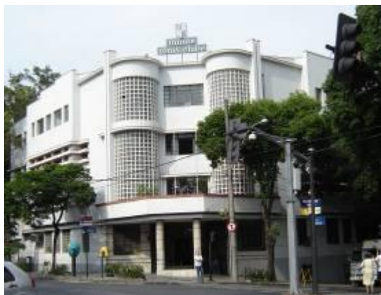
Figura 118: Sede Social do Minas Tênis Clube na Rua da Bahia, gerou TDC em 2001.
