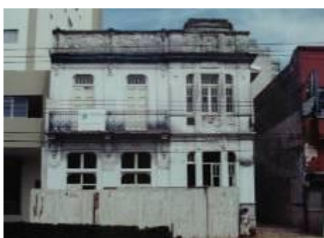
Figura 92: Casa Amarela antes do restauro em 2000 Fonte: Acervo do IPPUC
