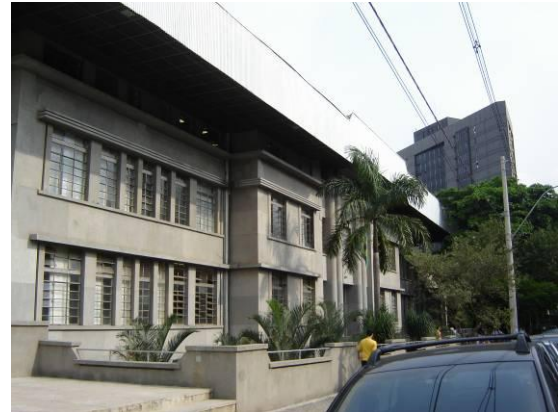
Figura 165: Instituto Isabela Hendrix em outubro de 2008 – Fachada da Rua da Bahia
