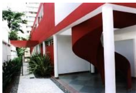
Figura 82: Escada em espiral da Casa Vilanova
