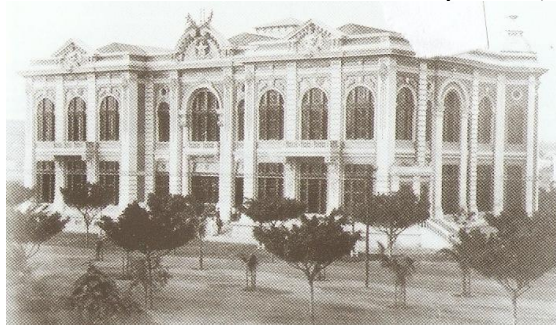
Figura 109: Antigo prédio dos Correios e Telégrafos (demolido)
