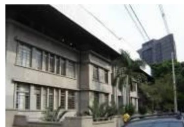
Figura 125: Imóvel do Instituto Isabela Hendrix, Art Decó na Rua da Bahia, 2020.
