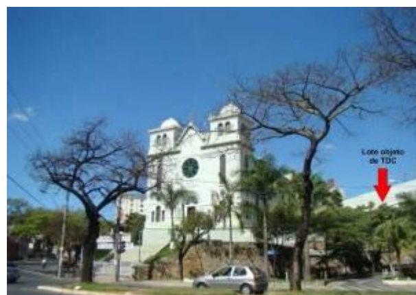
Figura 115: Igreja Santa Efigênia com destaque para o terreno vizinho que gerou TDC
