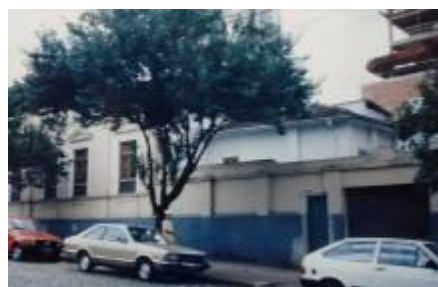
Figura 138: Barracões ao fundo na Rua Rio Grande do Sul.
