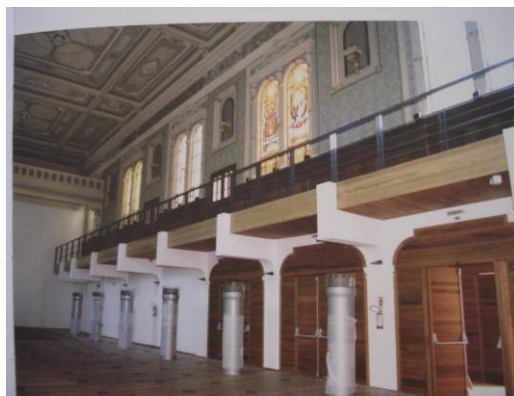
Figura 102- Capela após o restauro Fonte: Boletim Casa Romário Martins, 2007, p.87.
