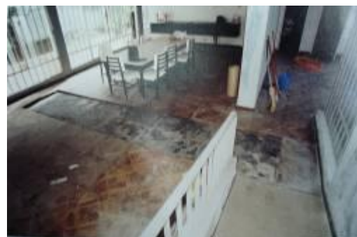
Figura 84: Sala principal da Casa Vilanova Artigas antes do restauro Fonte: Banco de dados da SMU
