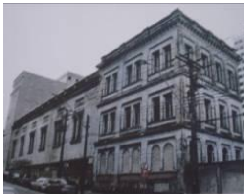
Figura 100- Capela antes do restauro Fonte: Boletim Casa Romário Martins, 2007, p.71.
