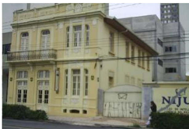
Figura 91: Casa Amarela após recuperação em 2004 – com nova edificação aos fundos
