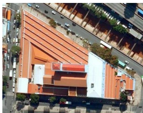
Figura 160: Quarteirão do Conjunto Arquitetônico do Oiapoque totalmente ocupado em 2009.
