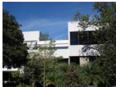
Figura 75: Prédio aos fundos do Palacete Leão Junior
