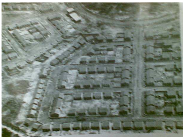
4.11 O IBES em construção: parte da praça e duas 'pétalas' já edificadas. A casa alinhada com a rua, na parte inferior da foto, foi retirada posteriormente, para o acesso à escola.
