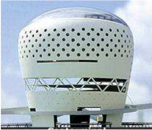
1.7 Zeebrugge, 1989: Terminal Aquaviário.
