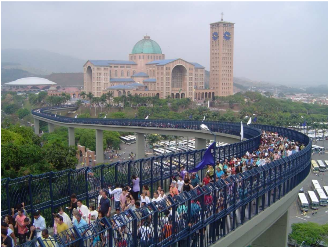
Figura 74: Vista da passarela de ligação entre os dois santuários em Aparecida do Norte. Fonte: Viviany Nogueira, 2007
