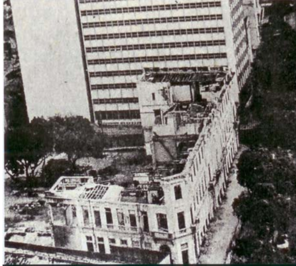
Figura 32: Demolição do Grande Hotel. Fonte: Correa, D. & Nunes, L. in Falcão, 2007.
