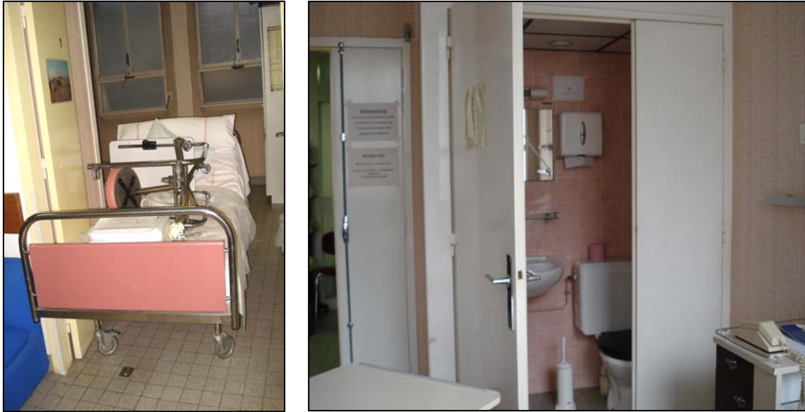
FIGURA 97 – Passagem de uma cama pela porta do quarto, à esquerda, e banheiro do quarto, à direita
