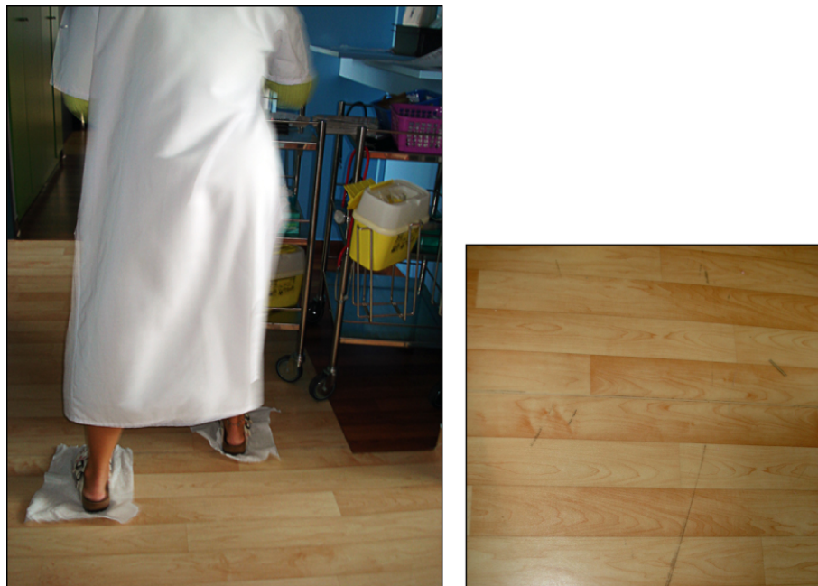
FIGURA 74 – Patinação sobre o piso úmido (à esquerda) e marcas no piso (à direita) – Hospital-dia VIH posterior ao projeto Fonte: Elaborado pela autora em 2008.
