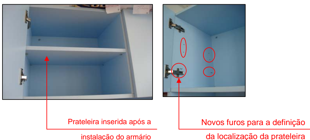
FIGURA 128 – Inserção de prateleiras no armário após a execução Fonte: Elaborado pela autora em 2008.
