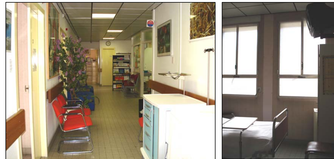
FIGURA 27 – Piso cerâmico, forro de gesso removível, luminárias embutidas e janelas do hospital-dia VIH – 1º pavimento. Fonte: Elaborado pela autora em 2008.
