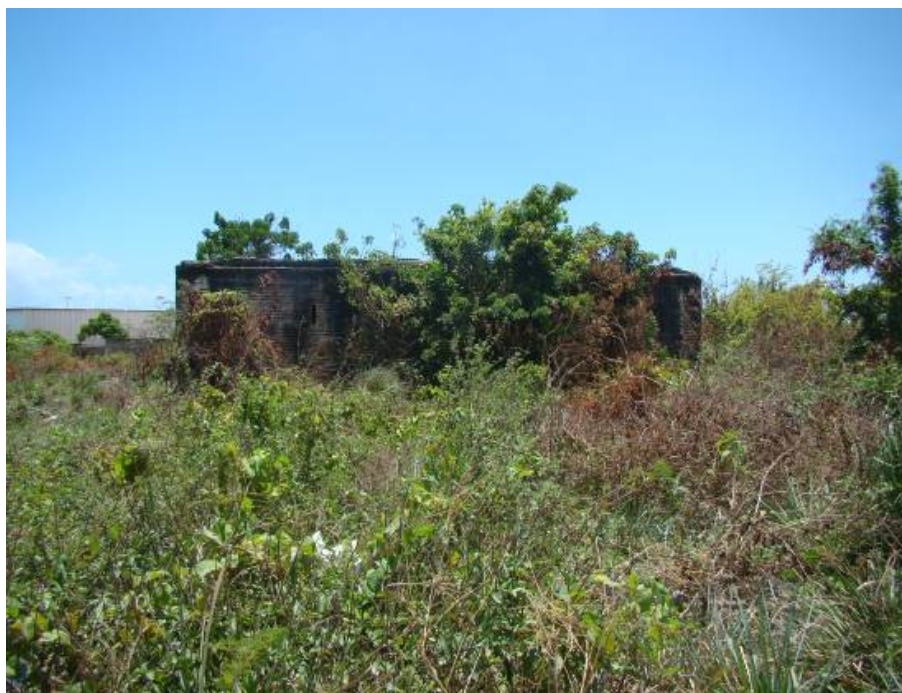
Figura 41 Ruína da Casa da Pólvora
