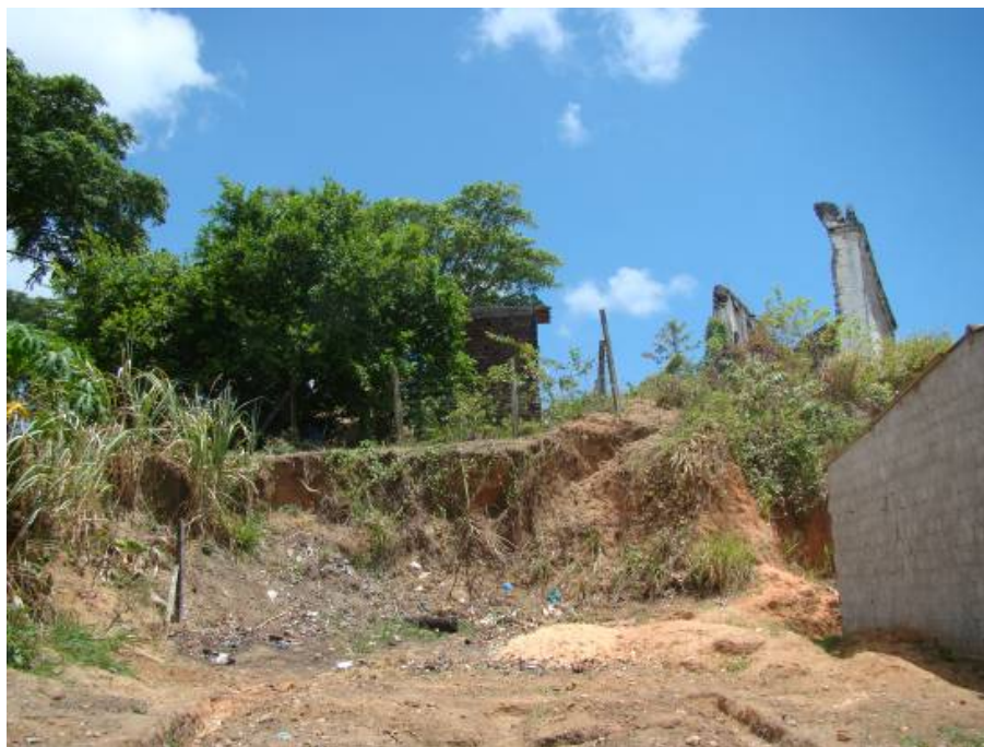
Figura 40 Ruína da Capela de Santa e a escavação do morro
