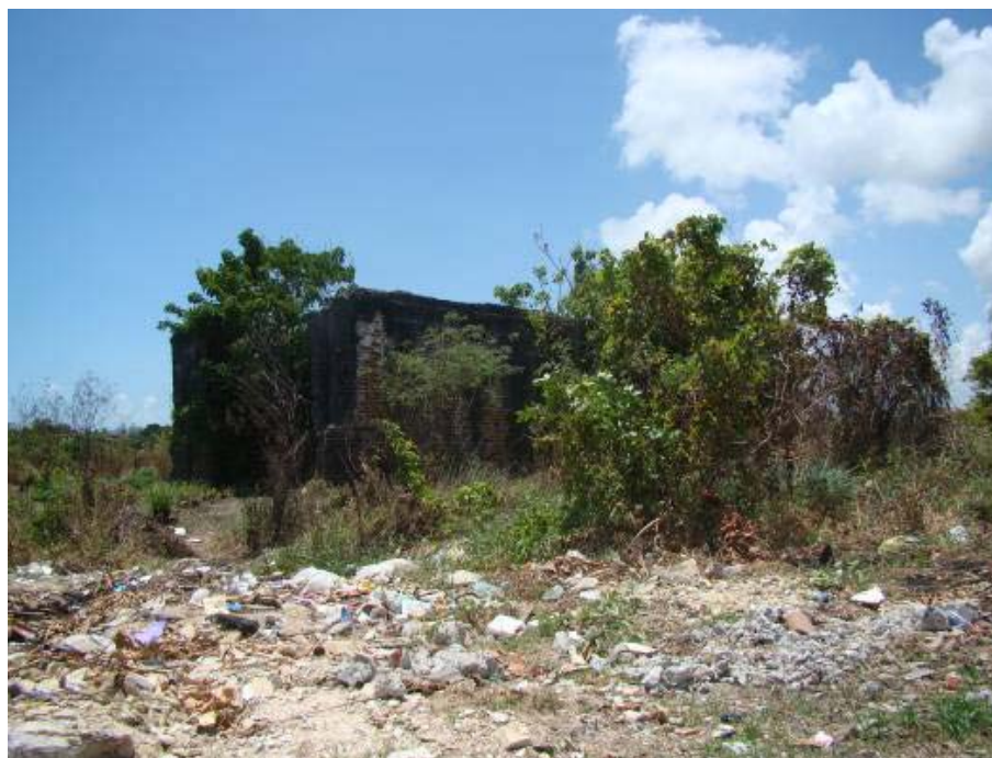
Figura 17 Ruína da Casa da Pólvora
