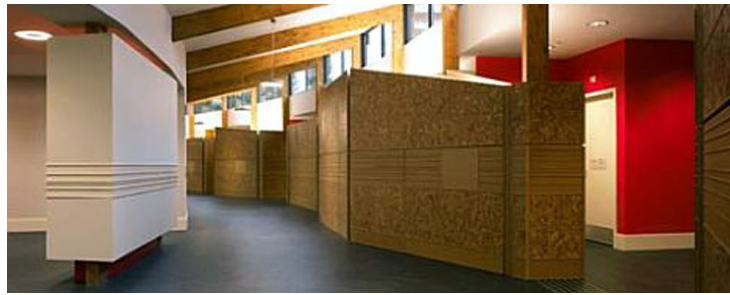
Fig. 2.28 – O material de revestimento contribuindo na percepção do espaço. O movimento da superfície evita a formação de ecos no local.
