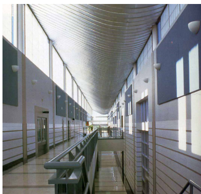
Fig. 2.5 – Circulação com teto não plano e uso de material absorvente sobre as paredes
