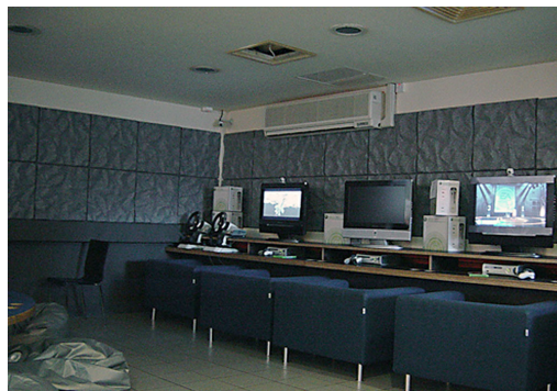
Fig. 2.29 – sala de informática, revestimento das paredes com material absorvente, uso de poltrona estofada auxiliando na redução da reverberação.
