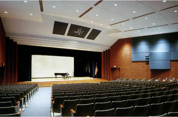
Fig.2.33 – Auditório com paredes em tijolo maciço, placas absorventes, teto direcionando o som Fonte: Educational Facilities 1995-96, The American Institute of Architects Press
