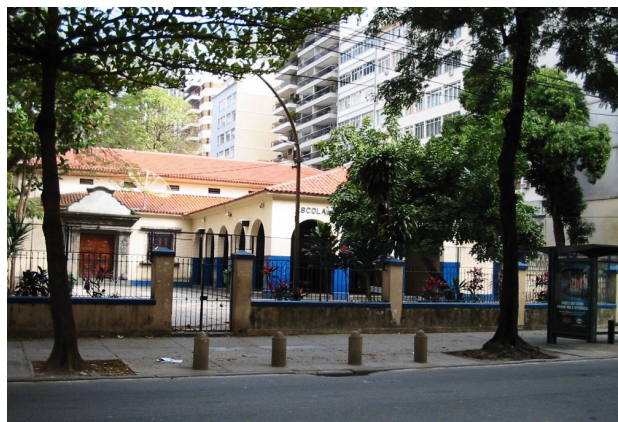
Fig. 2.25 – Escola Barão de Itacurussá: vista da entrada para secretaria e pátio coberto Fonte: Foto do autor
