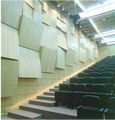
Fig. 2.34 – Aplicação de placas difusoras na parede lateral, curva de visibilidade acentuada. Fonte: Foto Carolina Serra
