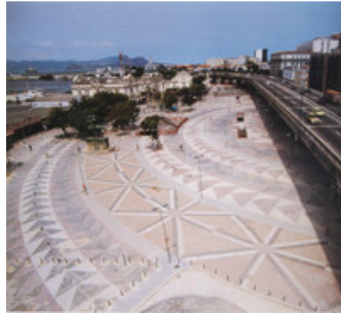
Figura 33 Foto da esplanada da Praça XV depois da reforma realizada em 1996, no final da gestão César Maia. À direita, o viaduto perimetral. Fonte: Chiavari: 1998, p.18.
