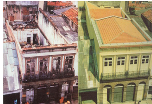
Figura 37 Cortiço localizado na rua Sacadura Cabral, na bairro da Saúde. Exemplo do estado de deterioração da edificação antes da reforma e o imóvel recuperado depois das obras. Fonte: Porto do Rio: 2001, p.114-115.
