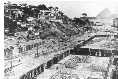
Figura 04 Obras de abertura da Av. Central, atual Av. Rio Branco. Observa-se à esquerda o Morro do Castelo, parcialmente demolido para implantação da avenida. Ao fundo, a Baía de Guanabara e o Pão de Açúcar. Fonte: Marc Ferrez – O Álbum da Avenida Central. 1982, p.30.
