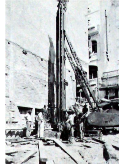
FIGURA 108 – Foto da Máquina Tipo XVII equipada com tubo de 400mm para estacas de 12 a 15 metros
