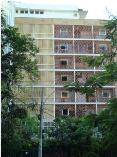
Foto 16: Painéis de cobogós protegendo a fachada de um dos edifícios do Parque Guinle. Foto da autora, 2010.
