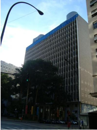
Foto 15: Painel de brises que protege a fachada do edifício do MEC. Foto da autora, 2010.
