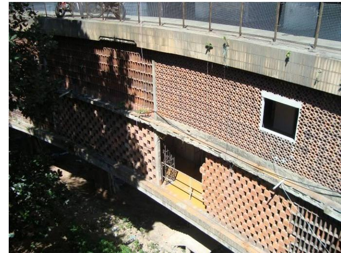
Foto 36: Detalhe dos danos e recomposições dos elementos cerâmicos que vedam a circulação do Bloco A. Foto da autora, 2010.
