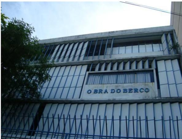
Foto 17: Obra do Berço (1937), Oscar Niemeyer. O painel de brises articulados protege a fachada oeste da radiação solar. Foto da autora, 2010.
